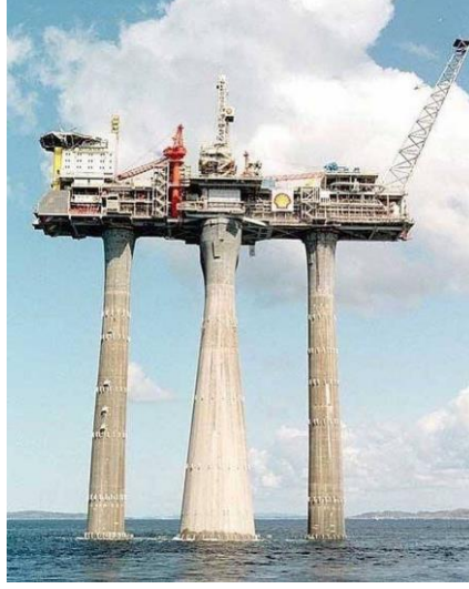
Şekil 1.6. Betonarme ağırlık yapısına ait örnek (Brutgroup, 2019)
