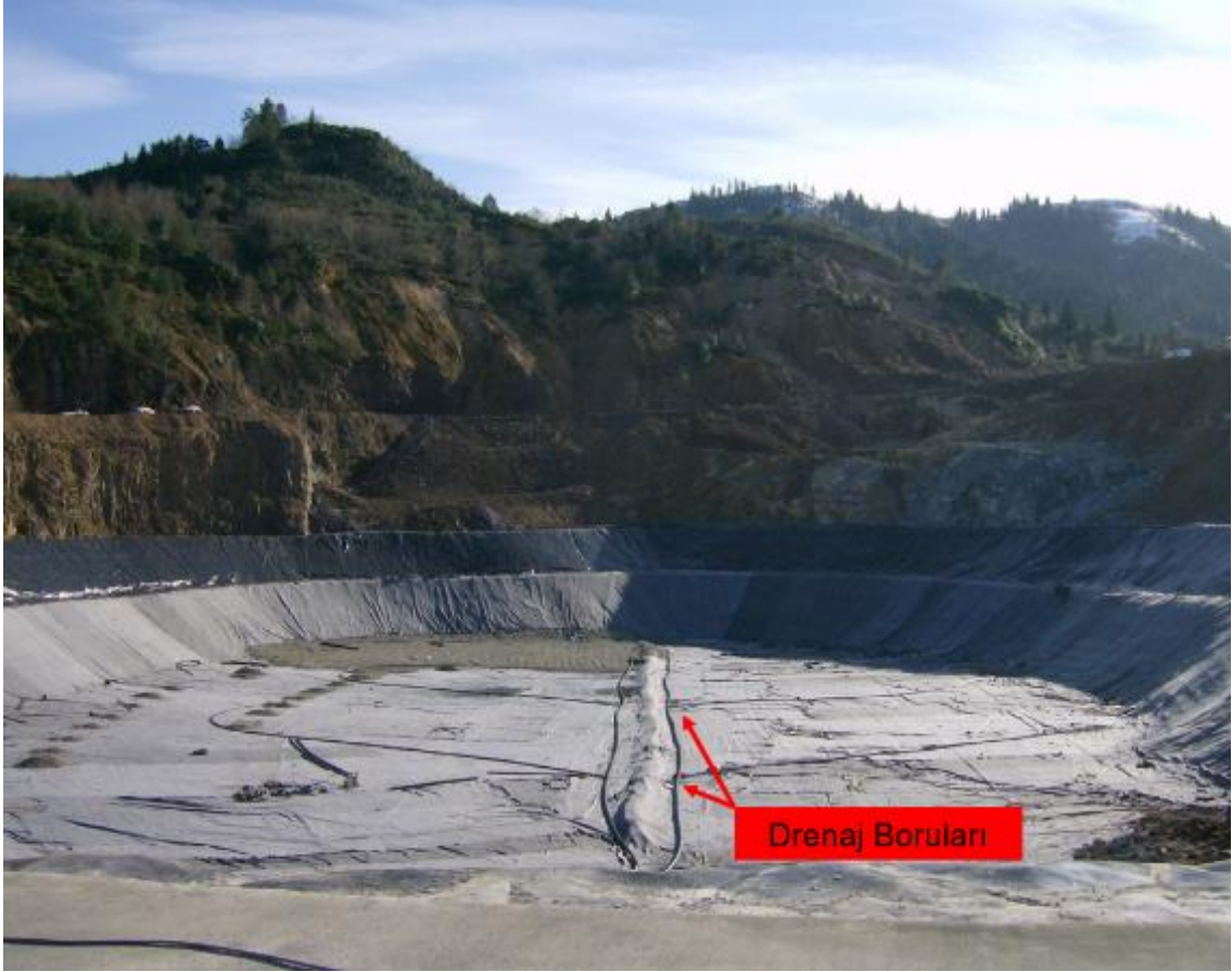
Şekil 15. Sızıntı suyu boru yerleştirilmesi ve drenaj malzemesi serilmesi (TRAB-Rİ KAB)
