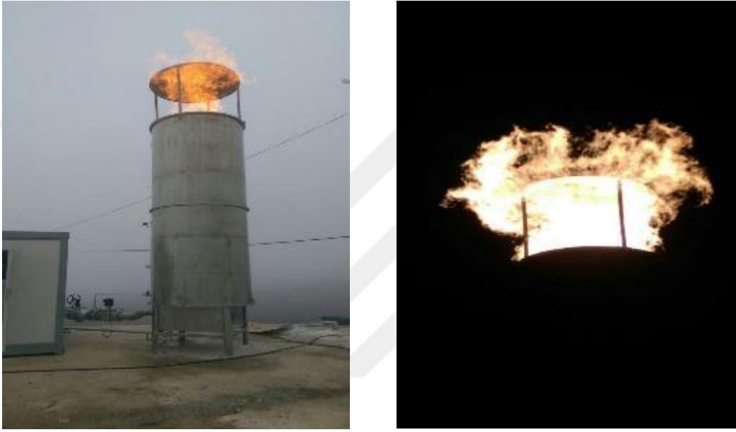
Şekil 43. Gaz yakma bacası (TRAB-Rİ KAB)
