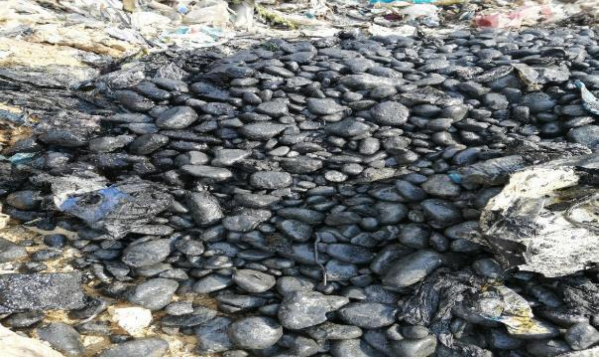
Şekil 64. Gaz toplama sisteminde standartlara uygun çakıl kullanılmaması (TRAB-Rİ KAB)
