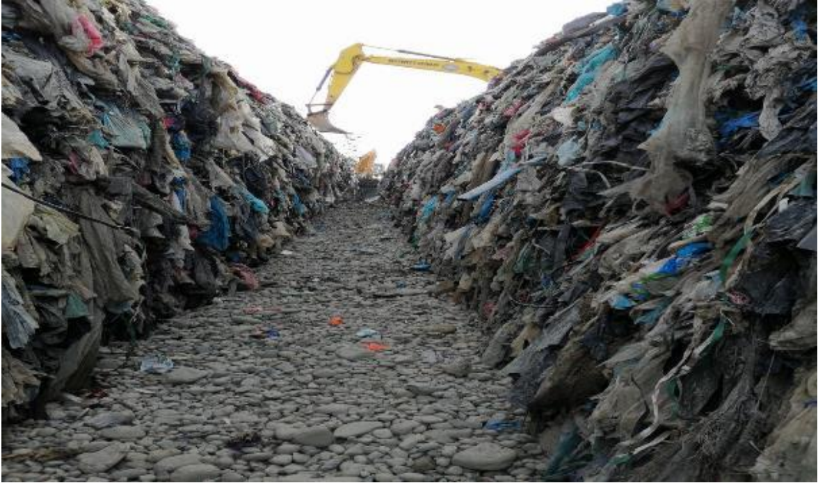
Şekil 63. Kanal boru altı ve üstü çakıl uygulaması (TRAB-Rİ KAB)
