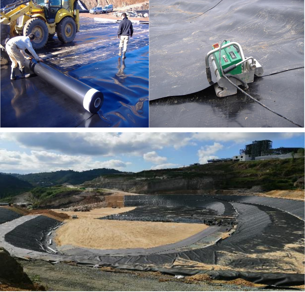
Şekil 12. Jeomembran serilmesi (TRAB-Rİ KAB)
