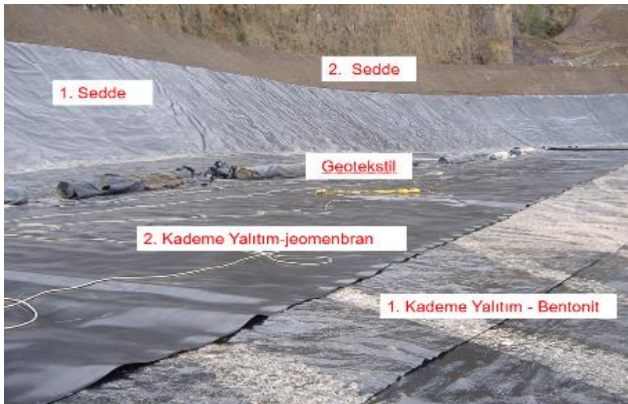
Şekil 14. Jeotekstil serilmesi (TRAB-Rİ KAB)
