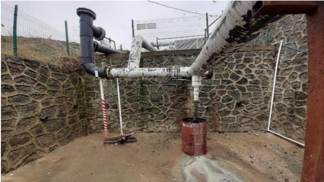
Şekil 72. Anahat kondens sifon görünüşü (TRAB-RI KAB)
