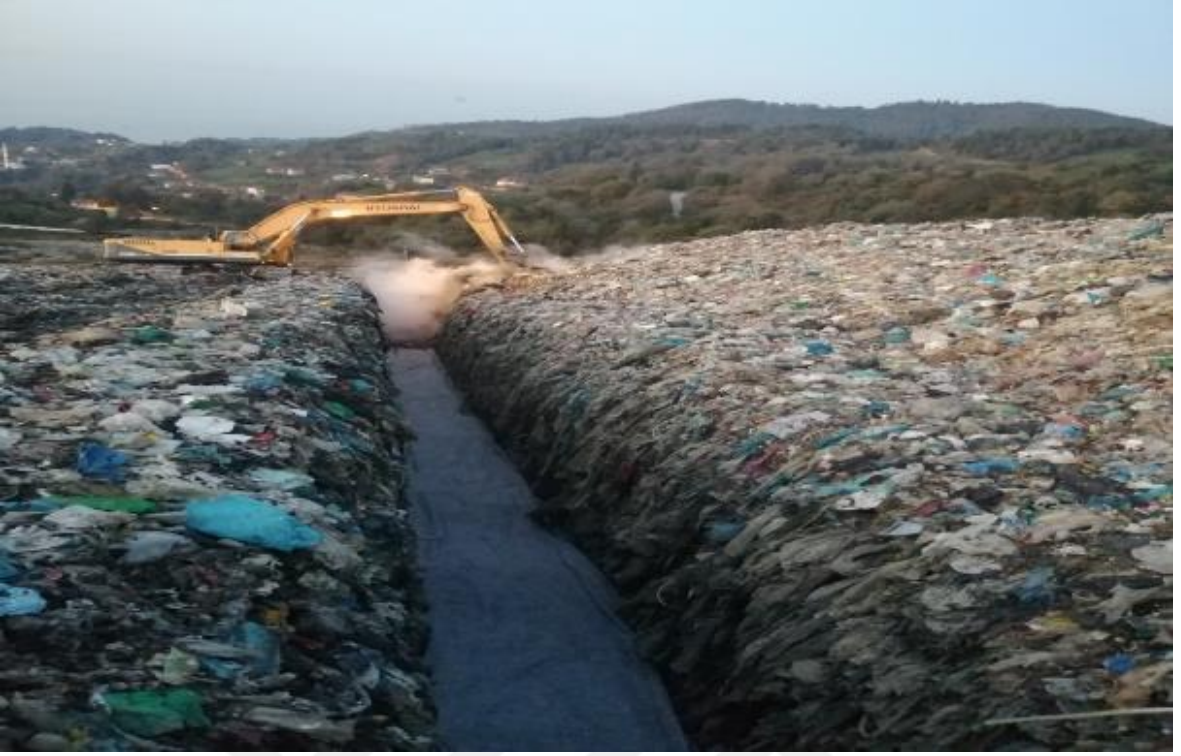
Şekil 66. Gaz toplama kanalına geotekstil serilmesi (TRAB-Rİ KAB)
