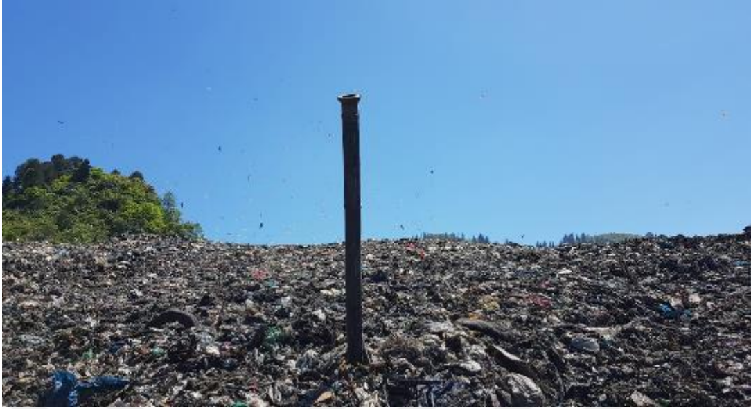
Şekil 68. Mevcut depolama alanı gaz çekme bacası (TRAB-Rİ KAB)
