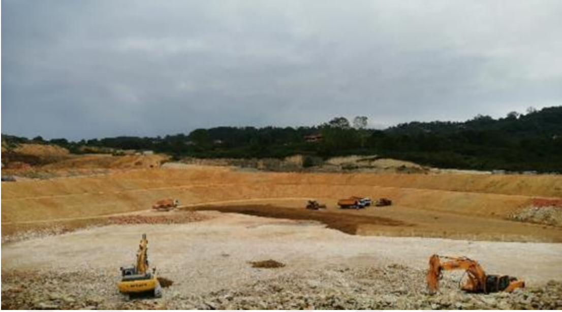
Şekil 11. Trabzon ili katı atık düzenli depolama sahası kil serilmesi (TRAB-Rİ KAB)
