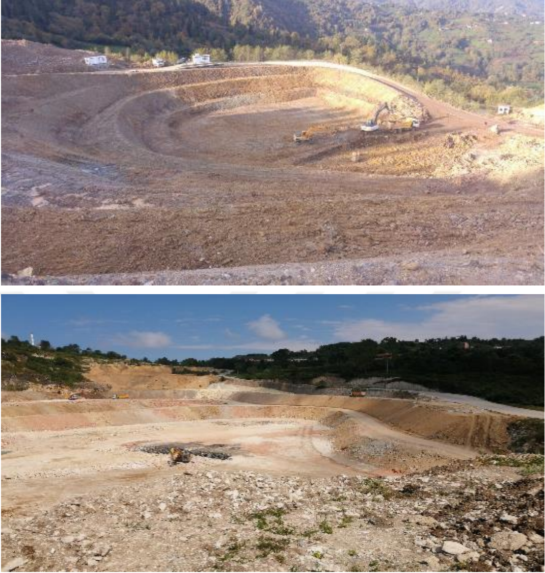
Şekil 9. Trabzon ili katı atık düzenli depolama sahası kazı çalışması (TRAB-Rİ KAB)
