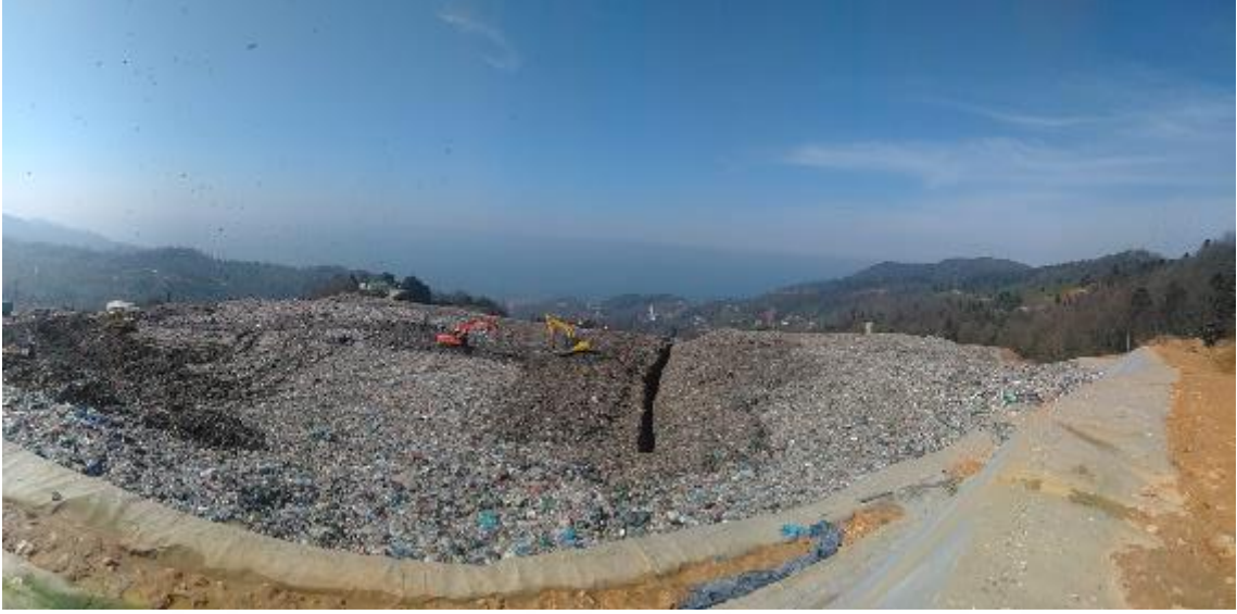
Şekil 60. Mevcut depolama alanında kanal açma çalışması (TRAB-Rİ KAB)
