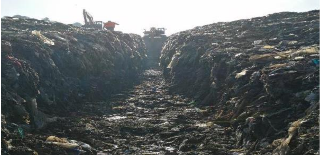
Şekil 61. Depolama sahasında kanal açılması (TRAB-Rİ KAB)
