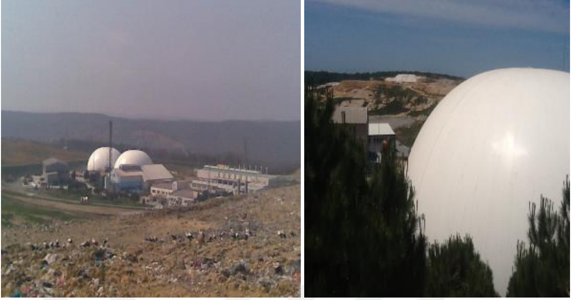
Şekil 44. Membran gaz depolama balonları (TRAB-Rİ KAB)
