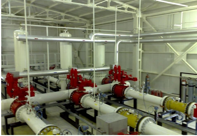
Şekil 3.17: Örnek bir RMS A istasyonunun iç görünüşü (GAZBİR, 2019).
