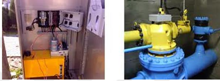
Şekil 3.20: Örnek bir aktuatörlü vana odası (GAZBİR, 2020).
