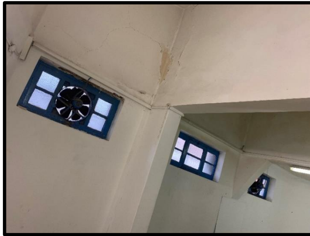
Resim 1.9 – Fırın kısmı havalandırma şekli iç cepheden görünüşü, 2021
