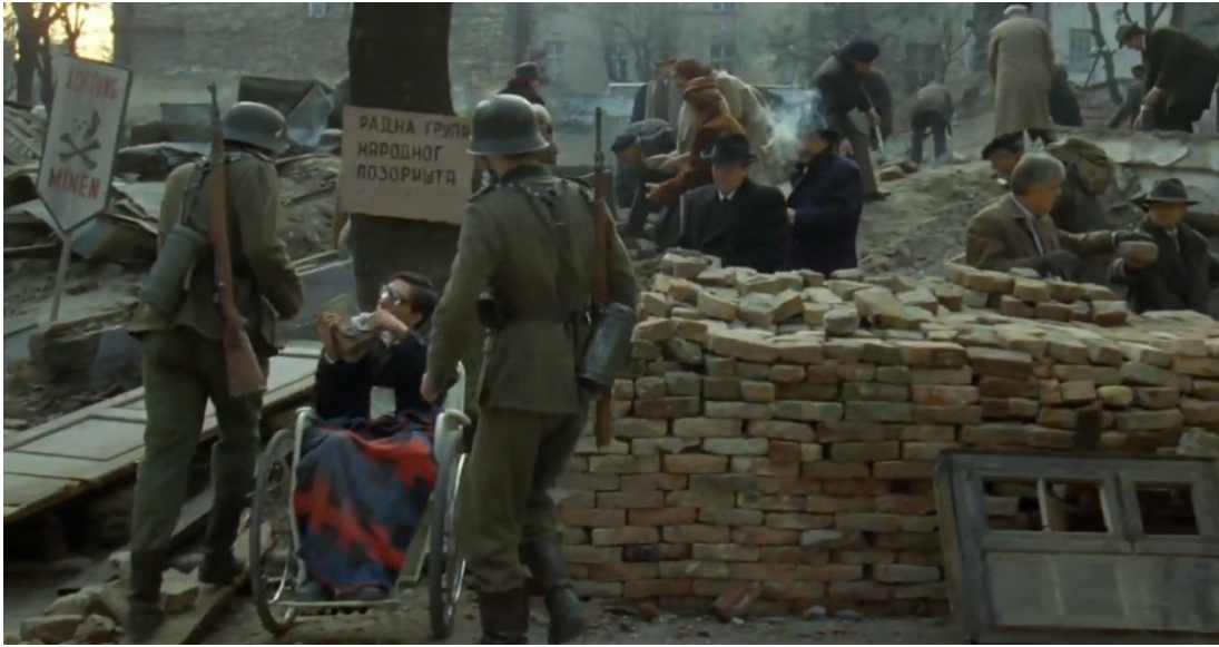
Şekil-39: Opera Binası Enkazı ve Tabelalar
