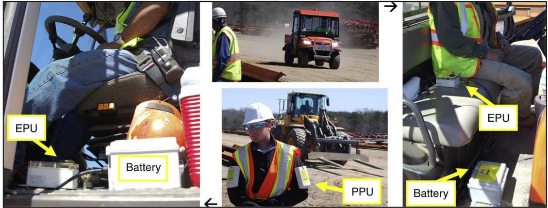
Şekil 3. 6 Sahada uygulanan alarm sisteminin cihazlarının açıklamalı gösterimi (Teizer, 2010).
