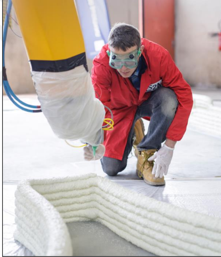
Şekil 3. 24 Poliüretan malzemeden duvar üreten 3D yazıcı örneği (Batiprint 3D, 2021).
