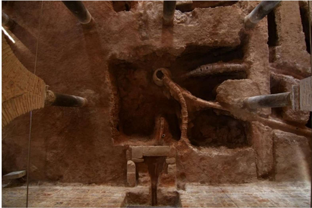
Lev. 95: Yivli Minare Külliyesi Cami Su Taşıma Sistemi
