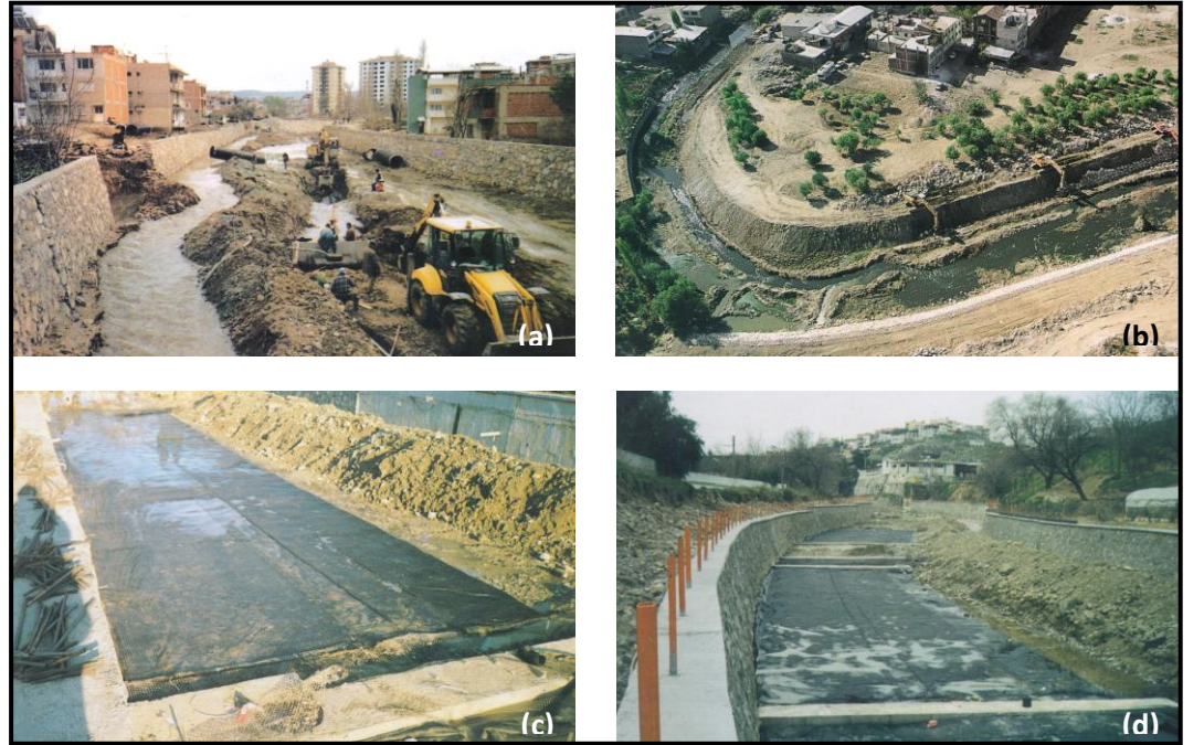
Şekil 3.11. Meles Deresi ıslah çalışmaları a) Yatak çalışmaları, b) Duvar çalışmaları, c) Kanal içi çalışmalar, d) Kanal içi çalışmalar (İZSU 2004)
