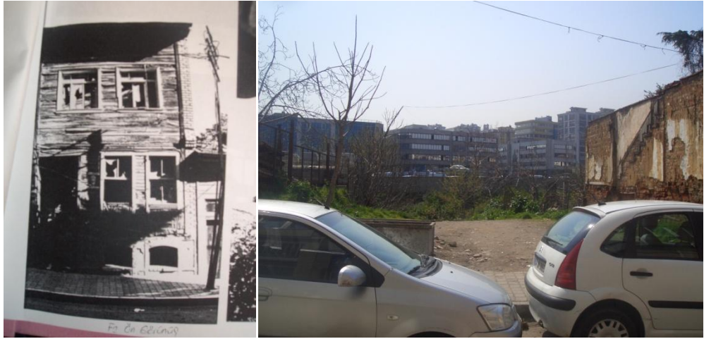
Şekil 7.49 : Yapı 450/21-Ahmet Rasim Sokağı, yok olan 24 kapı numaralı yapı.
