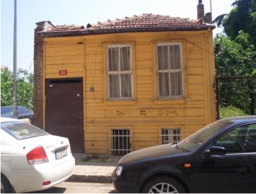
Şekil 7.50 : Yapı 450/23-Ahmet Rasim Sokağı,kullanılmayan 22 kapı numaralı yapı.
