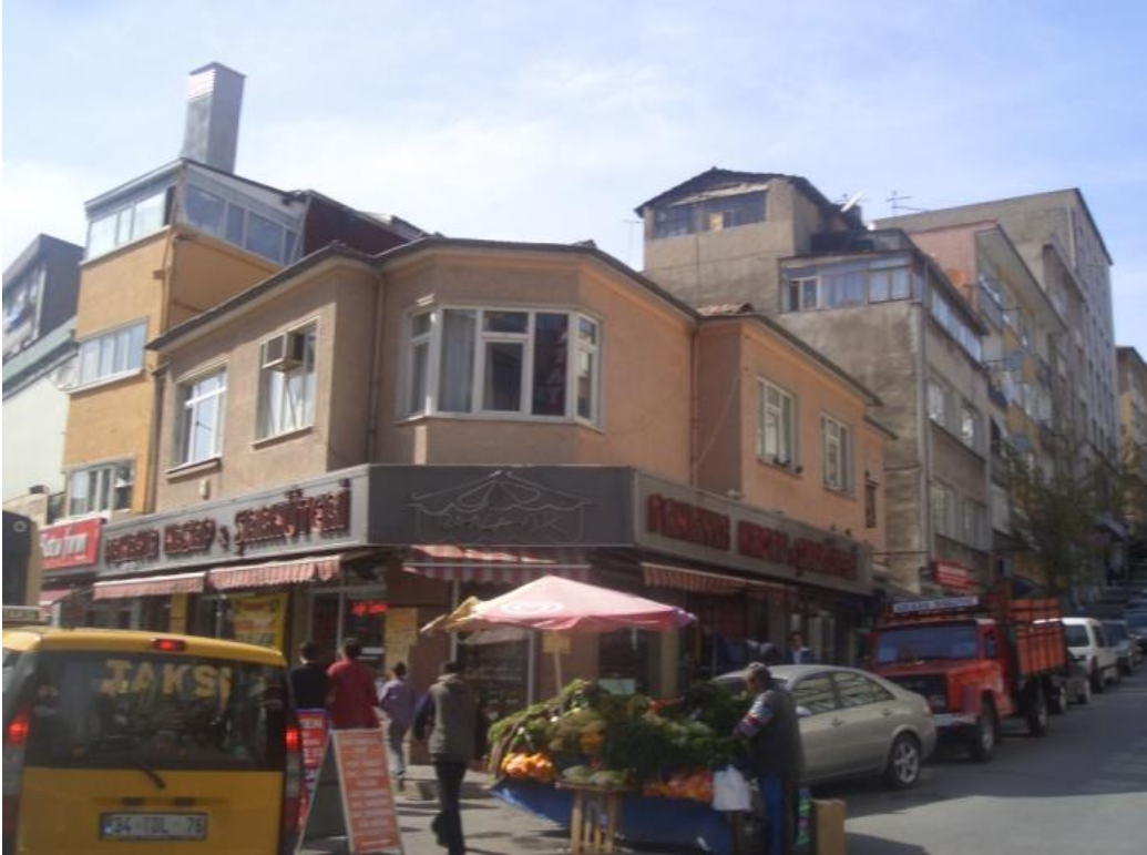
Şekil 7.85 : Yapı 491/1-Sarayardı Caddesi, 75 kapı numaralı yapı.
