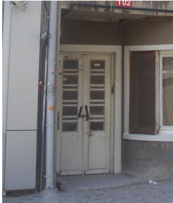
Şekil 4.41 : Sarayardı Caddesi, 40.parselde kullanılmayan yapı.
