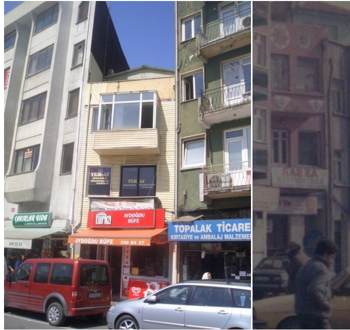
Şekil 7.67 : Yapı 468/3-Kurbağalıdere Caddesi, tadilat gören 63 kapı numaralı yapı.
