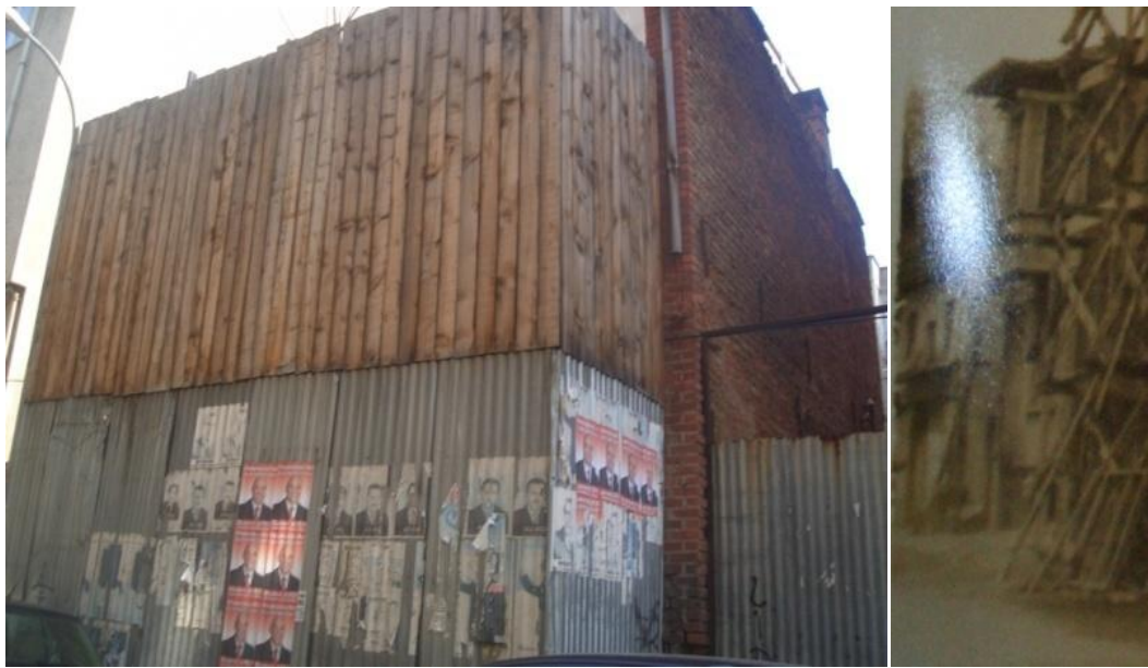
Şekil 7.4 : Yapı 445/15-Ali Ruhi Sokağı, yok olan 3 kapı numaralı yapı.
