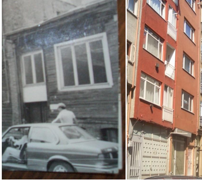
Şekil 7.7 : Yapı 446/23-Ali Ruhi Sokağı, yok olan 8 kapı numaralı yapı.
