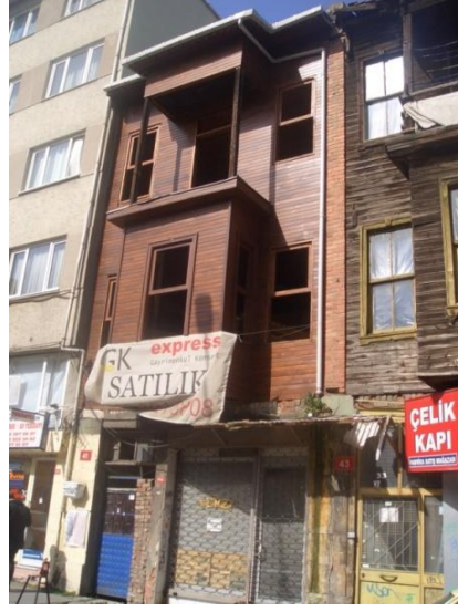
Şekil 7.98 : Yapı 1432/60-Sarayardı Caddesi, 41 kapı numaralı yapı.
