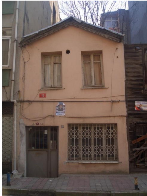
Şekil 7.15 : Yapı 448/7-Andelip Esat Sokağı, kullanılmayan 19 kapı numaralı yapı.
