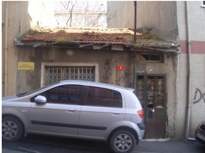
Şekil 7.87 : Yapı 491/7-Mehtap Sokağı, kullanılmayan 4 kapı numaralı yapı.
