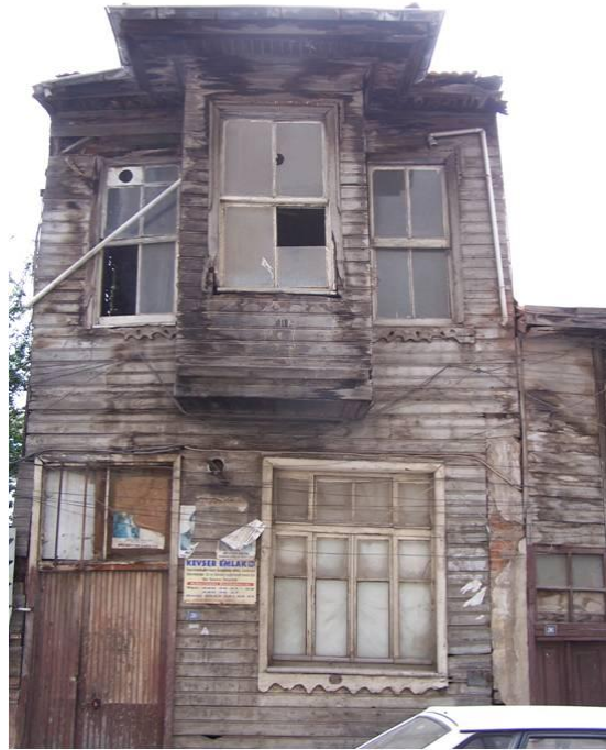
Şekil 7.44: Yapı 450/15-Ahmet Rasim Sokağı, kullanılmayan 38 kapı numaralı yapı.
