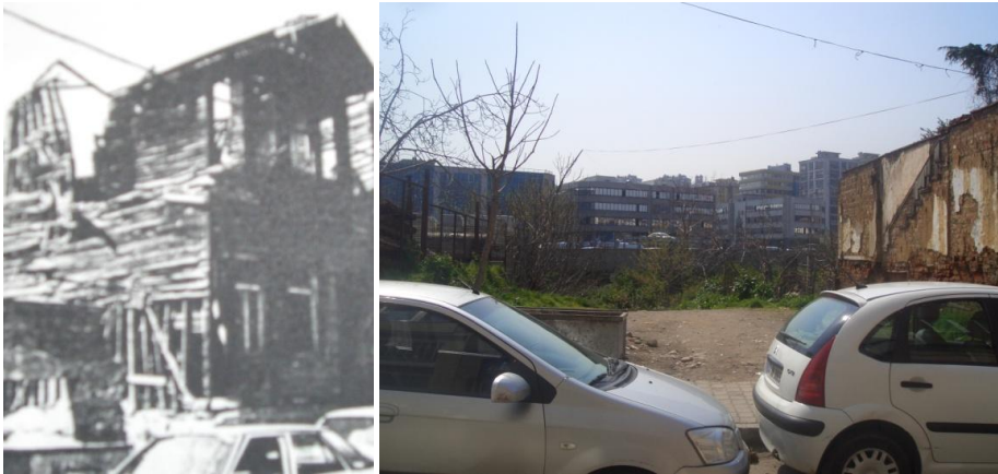
Şekil 7.48 : Yapı 450/21-Ahmet Rasim Sokağı,yok olan 26 kapı numaralı yapı.
