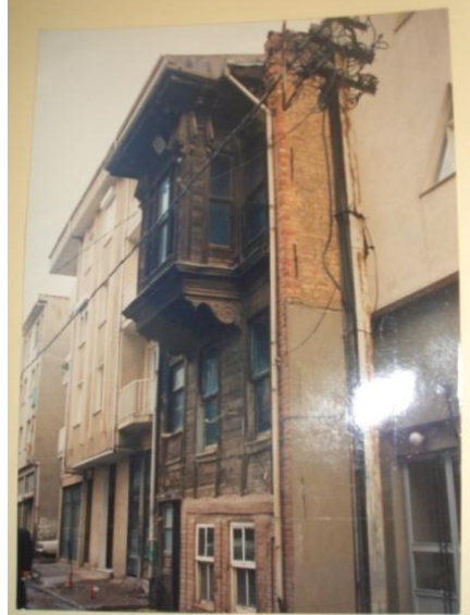
Şekil 7.60 : Yapı 450/45-Nabizade Sokağı, 47 kapı numaralı yapı.
