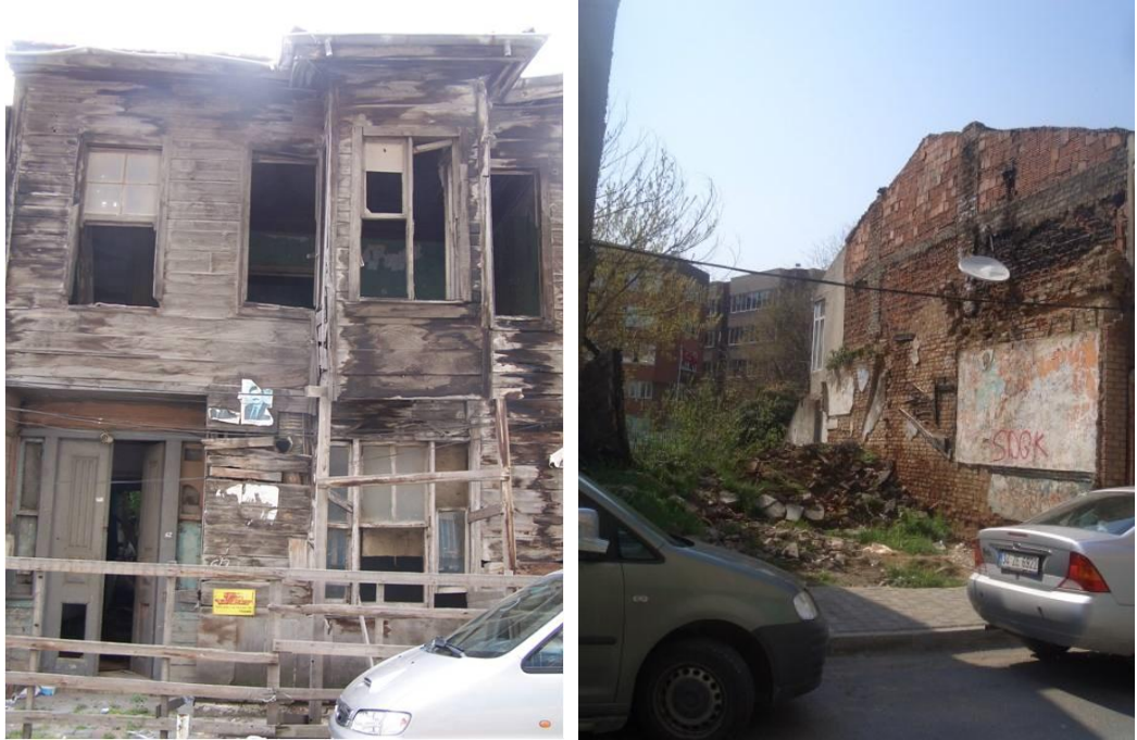
Şekil 7.36 : Yapı 450/2-Ahmet Rasim Sokağı, yok olan 62 kapı numaralı yapı.
