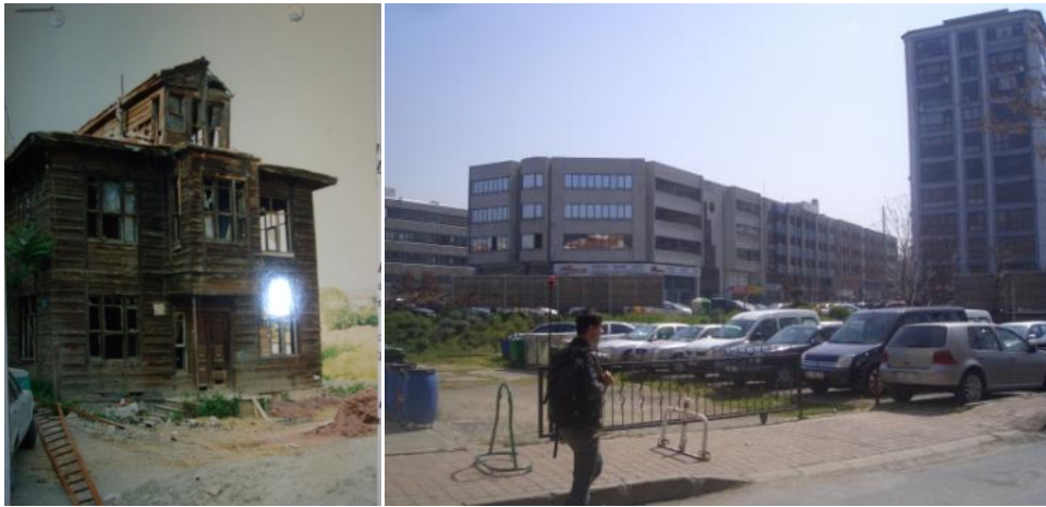
Şekil 7.61 : Yapı 450/48-Nabizade Sokağı, yok olan 53 kapı numaralı yapı.
