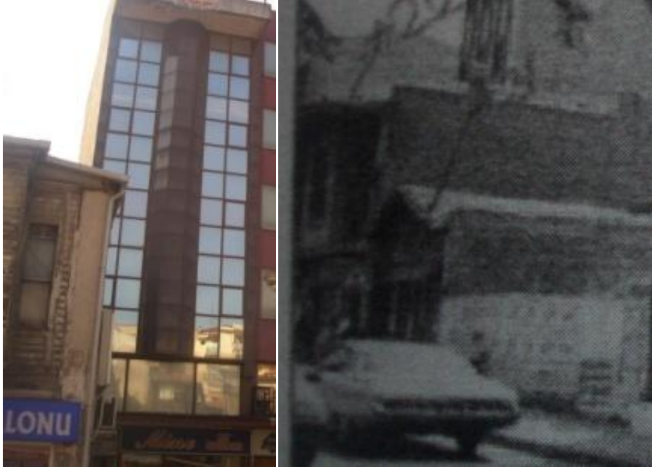
Şekil 7.22 : Yapı 448/21 - Kurbağalıdere Caddesi, yok olan 42 kapı numaralı yapı.
