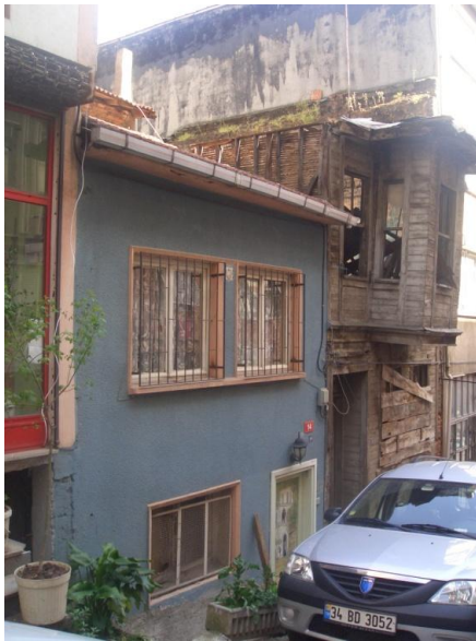
Şekil 7.90 : Yapı 491/11-Mehtap Sokağı,tadilat gören 14 kapı numaralı yapı.
