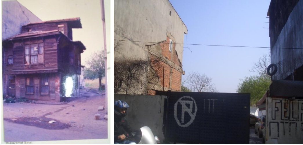
Şekil 7.59 : Yapı 450/43-Nabizade Sokağı, yok olan 39 kapı numaralı yapı.
