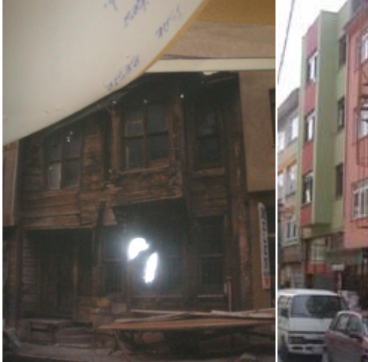
Şekil 7.62 : Yapı 451/43-Nabizade Sokağı, yok olan 6 kapı numaralı yapı.
