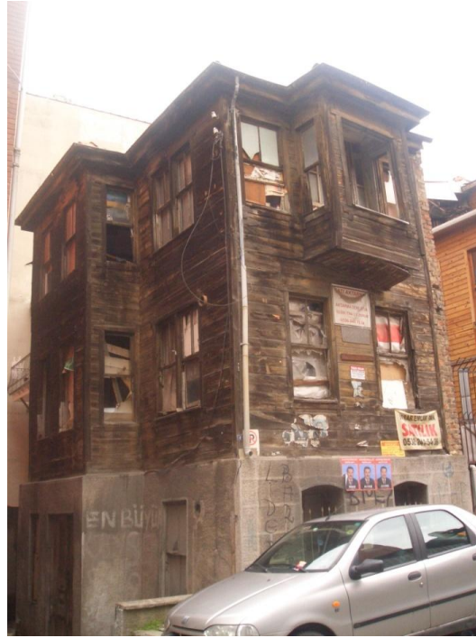
Şekil 7.32 : Yapı 449/36-Andelip Esat Sokağı, kullanılmayan 4 kapı numaralı yapı.
