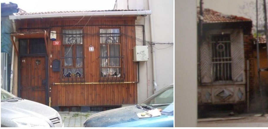
Şekil 7.47 : Yapı 450/18-Ahmet Rasim Sokağı, tadilat gören 32 kapı numaralı yapı.
