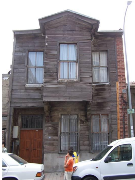
Şekil 7.40 : Yapı 450/10-Ahmet Rasim Sokağı, 46 kapı numaralı yapı.
