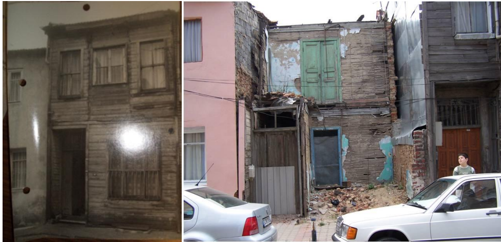
Şekil 7.39 : Yapı 450/9-Ahmet Rasim Sokağı, yok olan 48 kapı numaralı yapı.
