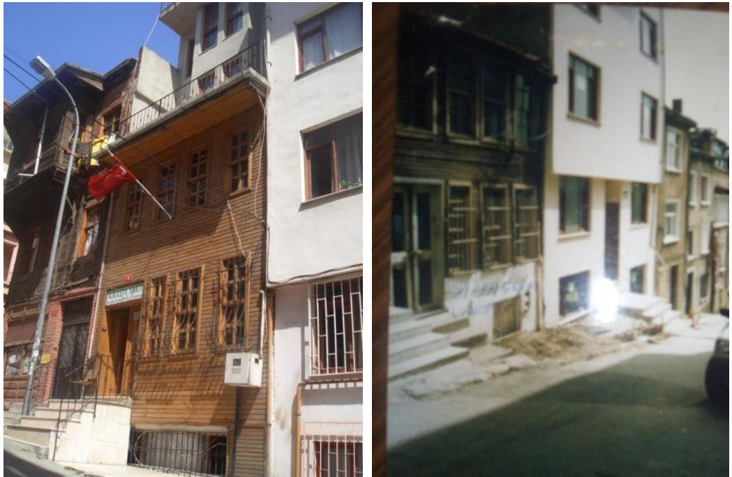
Şekil 7.64 : Yapı 459/18-Necip Usta Çıkmağı, 3 kapı numaralı yapı.
