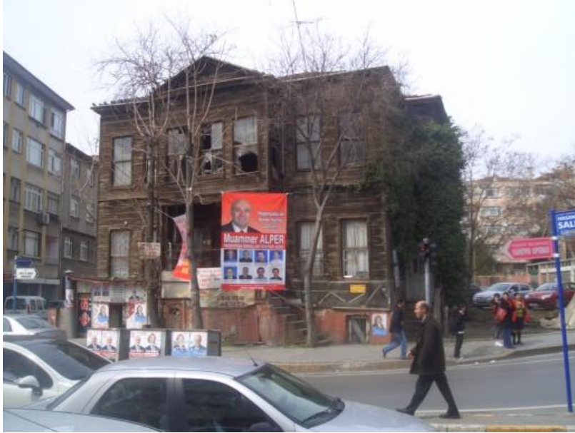
Şekil 7.83 : Yapı 469/16-Kurbağalıdere Cad., kullanılmayan 69 kapı numaralı yapı.
