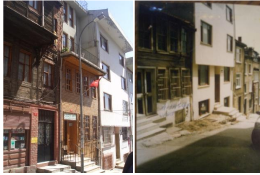
Şekil 5.19 : Hacı Recai Sokağı, 18.parselde bulunan yapının restorasyonu.
