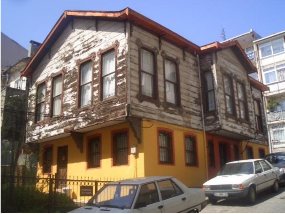
Şekil 7.71 : Yapı 468/50-Faik Bey Sokağı, 2 kapı numaralı yapı.
