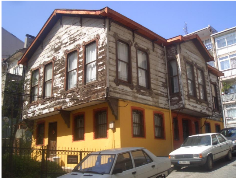
Şekil 4.27 : Faik Bey Sokağı, 50.parselde yeniden yapılan yapı.
