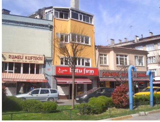
Şekil 5.16 : Sarayardı Caddesi'nde bulunan kagir yapılar.
