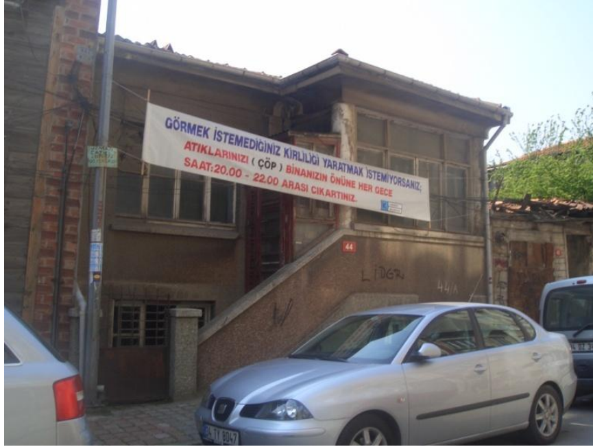
Şekil 7.41: Yapı 450/11-Ahmet Rasim Sokağı, kullanılmayan 44 kapı numaralı yapı.
