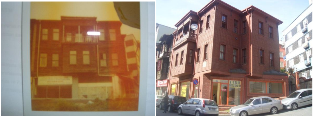
Şekil 7.96 : Yapı 1432/58-Sarayardı Caddesi, 45 kapı numaralı yapı.
