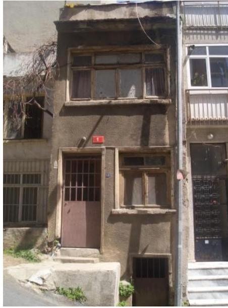
Şekil 7.70 : Yapı 468/45-Şair Sururi Sokağı, kullanılmayan 1 kapı numaralı yapı.
