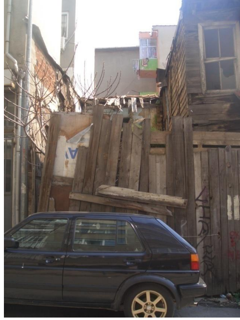
Şekil 7.3 : Yapı 445/7-Ali Ruhi Sokağı, yok olan 15 kapı numaralı yapı.
