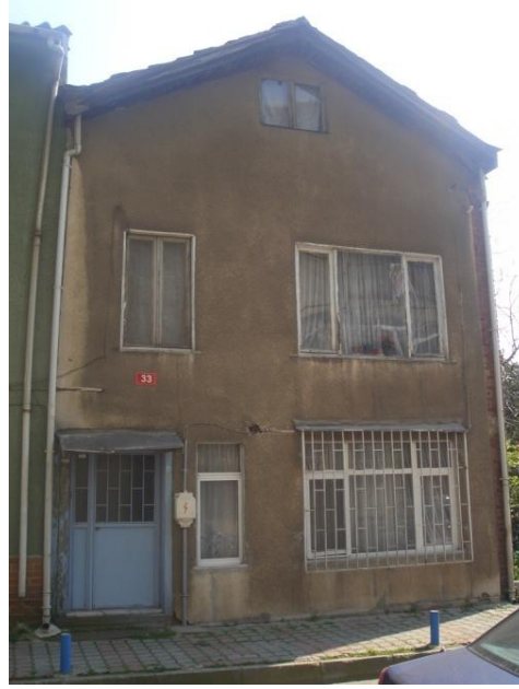
Şekil 7.56 : Yapı 450/35- Andelip Esat Sokağı,tadilat gören 33 kapı numaralı yapı.
