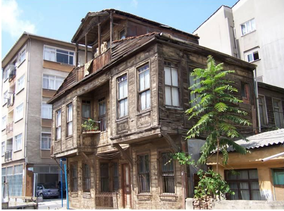
Şekil 7.1 : Yapı 445/5-Ahmet Rasim Sokağı, 29 kapı numaralı yapı.
