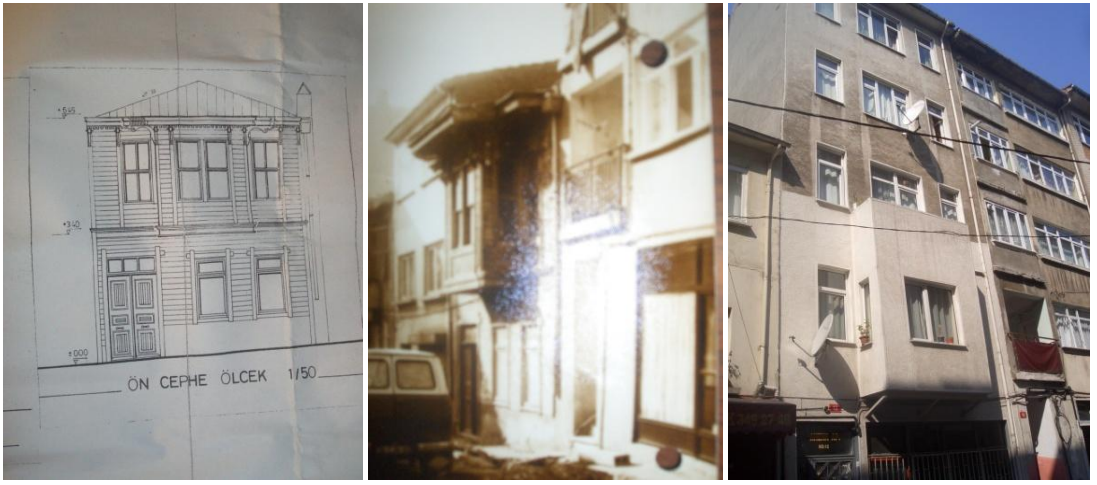
Şekil 7.25 : Yapı 448/29-Kurbağalıdere Cad.,yeniden yapılan 46 kapı numaralı bina.
