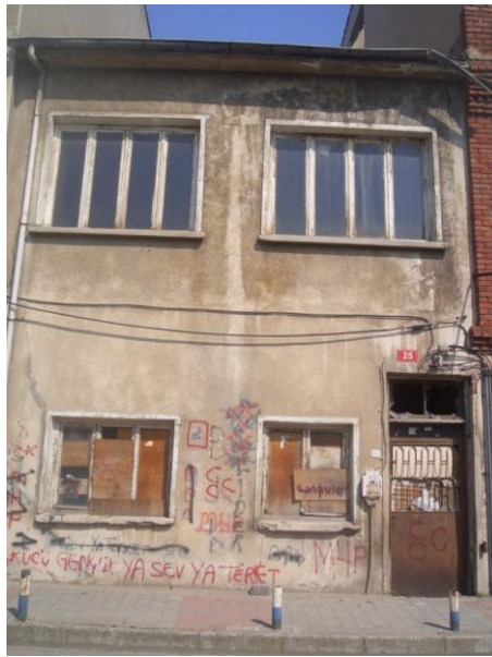
Şekil 7.6 : Yapı 446/2-Ahmet Rasim Sokağı, kullanılmayan 25 kapı numaralı yapı.
