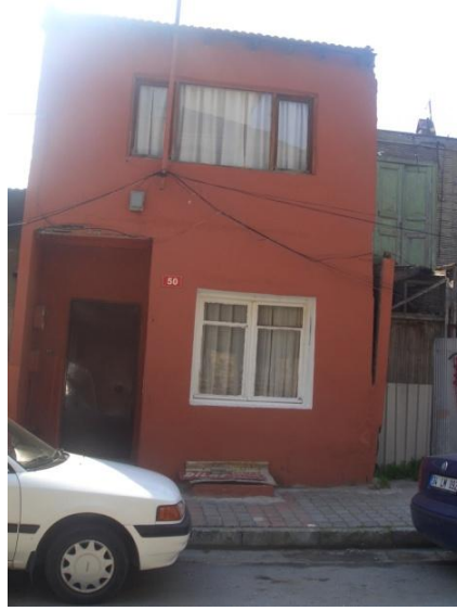
Şekil 7.38 : Yapı 450/8-Ahmet Rasim Sokağı, tadilat gören 50 kapı numaralı yapı.
