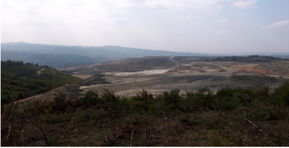
Şekil 3.2 : Açık ocak mevcut döküm sahasının görünümü.
