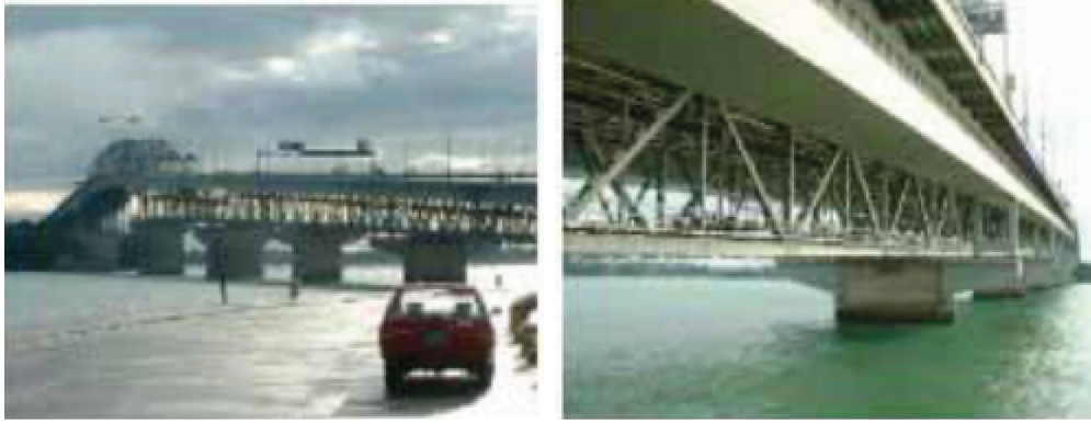
Şekil 2.22: Yeni Zelanda Auckland Limanı'ndaki termal spreyle kaplanan köprü [45].
