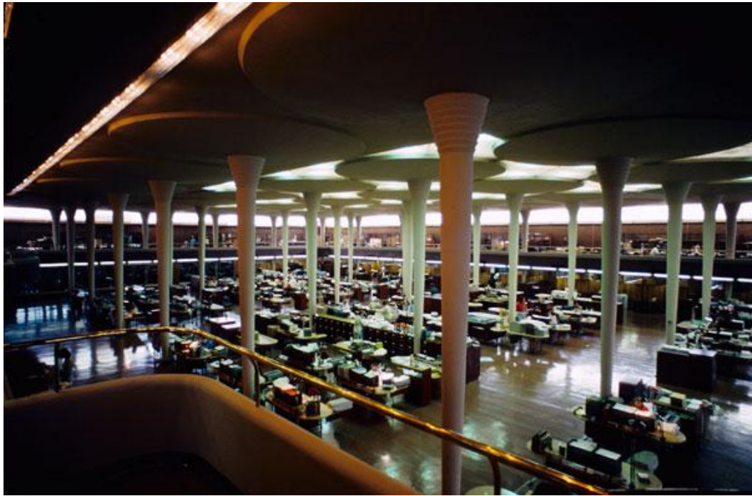
Şekil 3.29. Johnson Wax binası’nın ‘nilüfer yaprağı’ kolonları, Frank Lloyd Wright [41].
