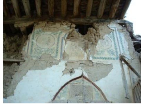
Foto. 113: Denizli, Çivril, Savran Köyü Camii, son cemaat yeri, güney cephe
