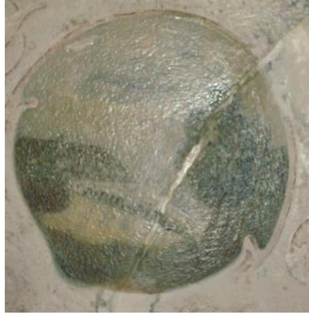
Foto. 599: Edirne Saadet Yardım- Bahattin Ögütmen Evi, iç mekan, zemin kat, güneydoğu oda, tavan
