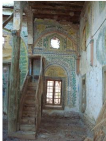
Foto. 120: Denizli, Çivril, Savran Köyü Camii, güney duvar, batı yanı
