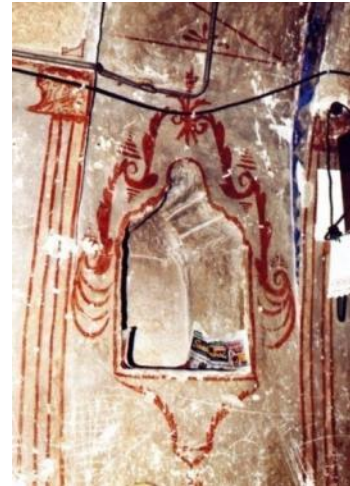
Foto. 539: Nevşehir, Avanos Yazıcılar Konağı (Mehmet Nuri Yazgan Evi), iç mekan, doğu duvar detay (M.A.Esmer'den)
