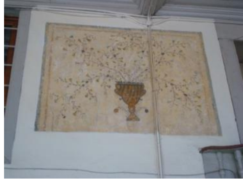
Foto. 229: Manisa, Akhisar, Zeytinliova Kara Osman-oğlu (Hacı Mustafa Ağa) Camii, son cemaat yeri, güney duvar, girişin batı yönündeki pano
