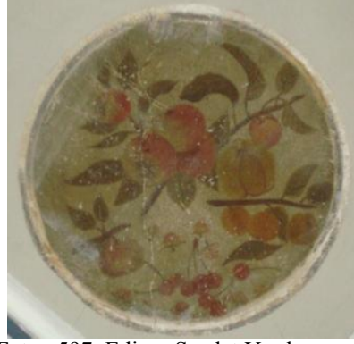
Foto. 597: Edirne Saadet Yardım- Bahattin Ögütmen Evi, iç mekan, zemin kat, güneydoğu oda, tavan detay
