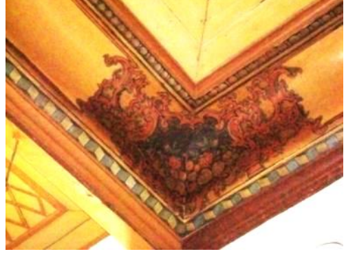
Foto. 233: Manisa, Akhisar, Zeytinliova Kara Osman-oğlu (Hacı Mustafa Ağa) Camii, tavan iç bükey kavisli geçiş kuşağı köşesi, detay
