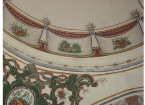
Foto. 205: Manisa (Merkez) Sultan (Valide Mesir) Camii, son cemaat yeri, kuzeydoğu kubbe, detay
