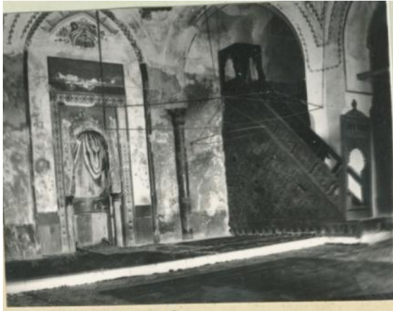
Foto. 11: Manisa Ulu Camii, güney duvarı, mihrap (V.G.M.'den)
