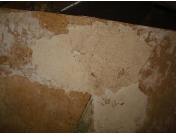
Foto. 5: Aydın, Karacasu, Geyre Köyü Camii (Afrodisias Müzesi Deposu-2010)
