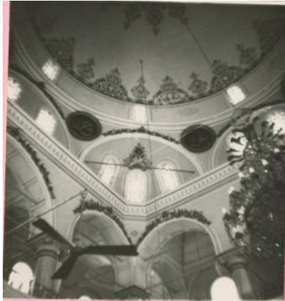
Foto. 136: İzmir (Merkez) Şadırvanaltı Camii, kubbe, güneydoğu tromp (restorasyon öncesi durumu) (VGM.'den)
