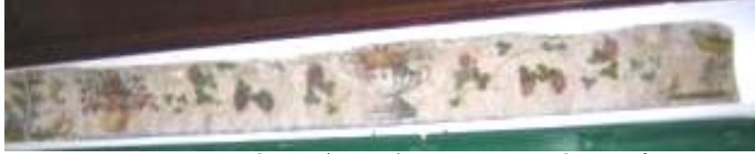
Foto. 560: Yozgat (Merkez) Nizamoğlu Konağı, iç mekan, Sofa, güneye bakan bölüm, kuzey tavan saçağı
