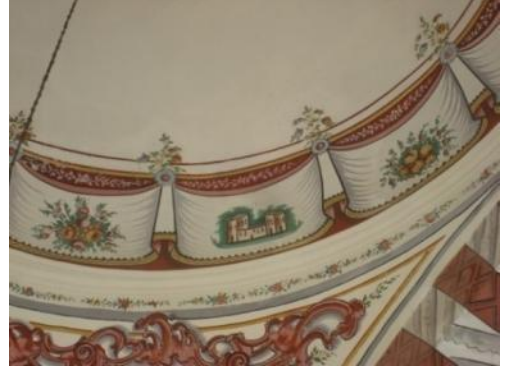
Foto. 203: Manisa (Merkez) Sultan (Valide Mesir) Camii, son cemaat yeri, kuzeydoğu kubbe, detay
