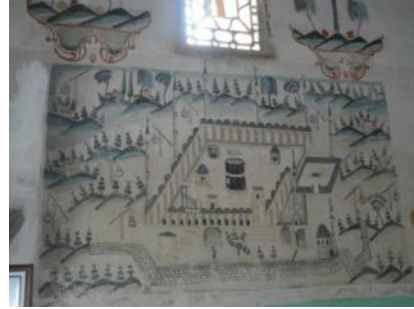
Foto. 680: Tokat, Zile, Tekke Köyü Şeyh Nusrettin (Nusrat) Türbesi, iç mekan, güney duvar detay
