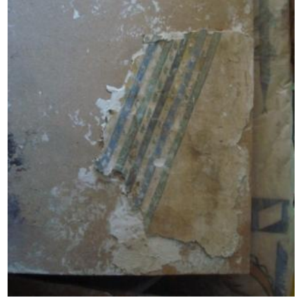
Foto. 2: Aydın, Karacasu, Geyre Köyü Camii (Afrodisias Müzesi deposu- 2010)
