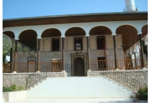
Foto. 81: Aydın, Koçarlı, Cincin Köyü Camii, kuzey cephe (genel görünüş)
