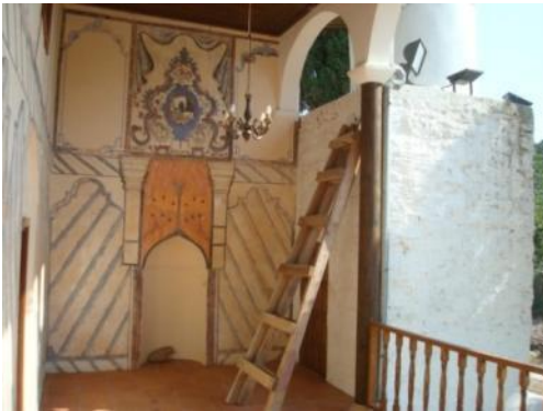
Foto. 84: Aydın, Koçarlı, Cincin Köyü Camii, batı cephe, güney duvar mihrabiye
