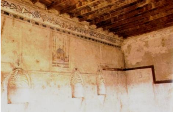
Foto. 534: Nevşehir, Avanos İhsan Balta Evi, iç mekan, doğu duvar (M.A.Esmer'den)
