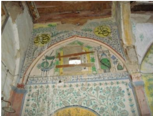
Foto. 119: Denizli, Çivril, Savran Köyü Camii, güney duvar, doğu yanı, detay
