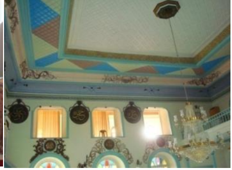
Foto. 368: Muğla (Merkez) Şeyh Camii, iç mekan, batı duvar
