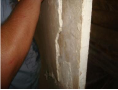
Foto. 3: Aydın, Karacasu, Geyre Köyü Camii (Afrodisias Müzesi Deposu-2010)
