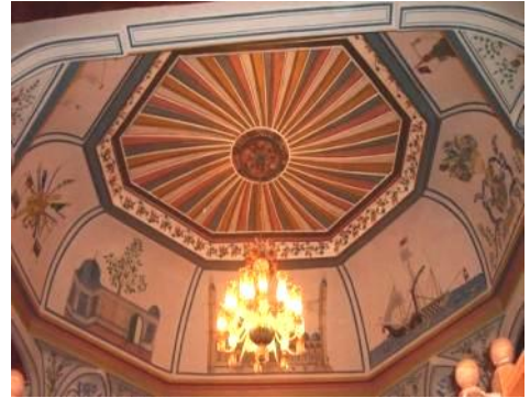
Foto. 516: Karaman (Merkez) Hacı Sami Tartan Evi, iç mekan, üst kat, Sofa kubbe (Ö.Yalçinkaya)
