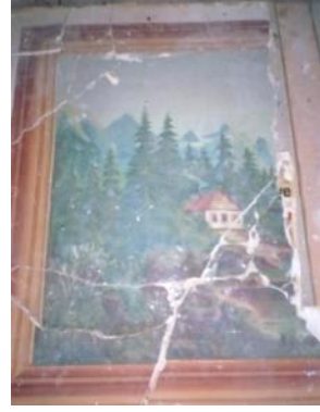
Foto. 603: Edirne Hafizoğlu Konağı, Onarım öncesi (Yavuz Günel)
