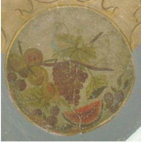
Foto. 598: Edirne Saadet Yardım- Bahattin Ögütmen Evi, iç mekan, zemin kat, güneydoğu oda, tavan detay
