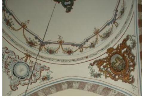
Foto. 215: Manisa (Merkez) Sultan (Valide Mesir) Camii, son cemaat yeri, batı kubbe, pandantifler
