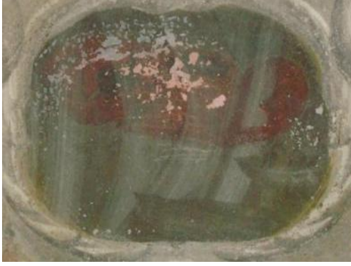
Foto. 596: Edirne Saadet Yardım- Bahattin Ögütmen Evi, iç mekan, zemin kat, güneydoğu oda, tavan detay
