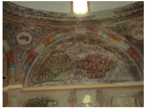
Foto. 73: Aydın, Koçarlı Cihanoğlu Camii, batı duvar detay
