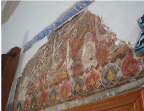
Foto. 619: Edirne Muradiye Camii, iç mekan, batı duvar
