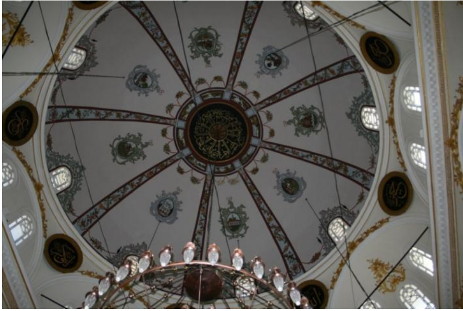
Foto. 135: İzmir (Merkez) Şadırvanaltı Camii, kubbe, harim, restorasyon sonrası durumu
