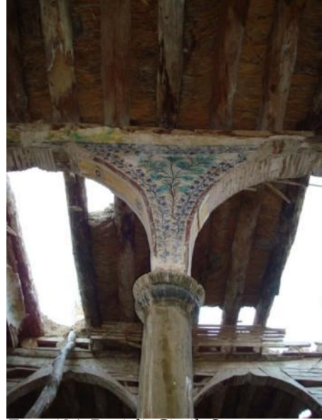
Foto. 124: Denizli, Çivril, Savran Köyü Camii, harim, ahşap destekleri taşıyan kemer köşelikleri, detay
