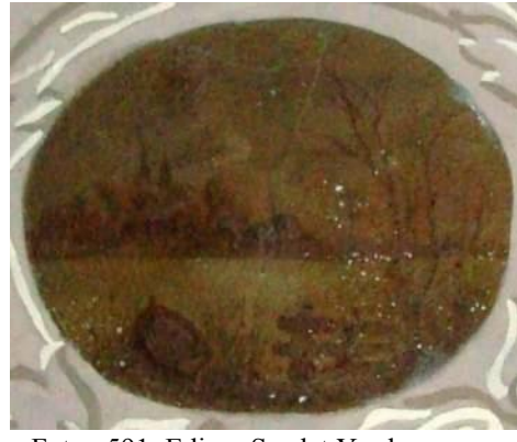
Foto. 591: Edirne Saadet Yardım- Bahattin Ögütmen Evi, iç mekan, zemin kat, kuzeydoğu oda tavan detay
