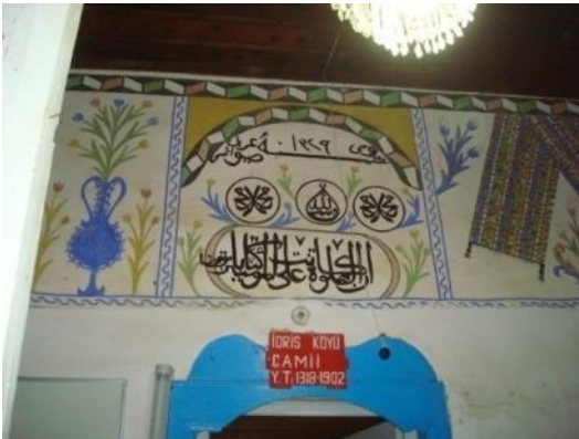
Foto. 17: Afyon, Dazkırı, İdris Köyü Camii, son cemaat yeri, güney duvar
