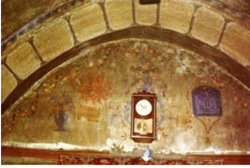
Foto. 540: Nevşehir, Avanos Yazıcılar Konağı (Mehmet Nuri Yazgan Evi), iç mekan, kuzey duvar (M.A.Esmer'den)
