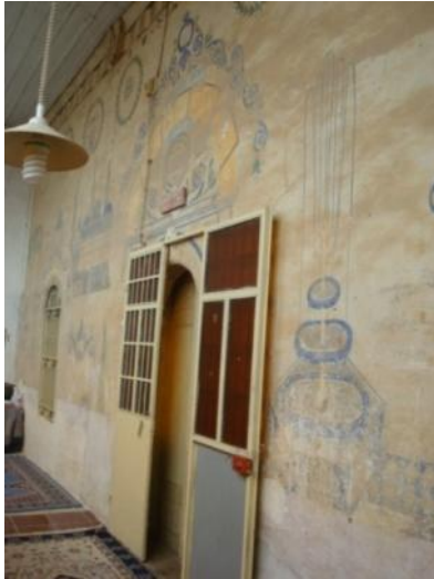
Foto. 41: Afyon, Dazkırı, Kızılören Köyü Camii, son cemaat yeri, güney duvar, harime giriş kapısı
