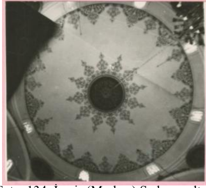
Foto. 134: İzmir (Merkez) Şadırvanaltı Camii, harim, kubbe (restorasyon öncesi durumu) (VGM.'den)
