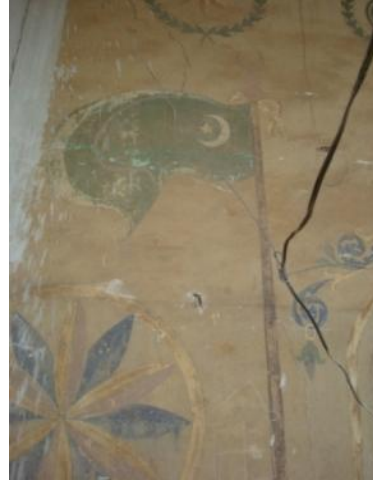
Foto. 40: Afyon, Dazkırı, Kızılören Köyü Camii, son cemaat yeri, güney duvarı doğu yönü, detay
