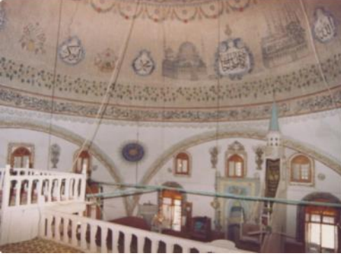
Foto. 49: Afyon, Sandıklı, Ulu Camii, harim, kubbe, restorasyon öncesi durumu (V.G.M.'den)
