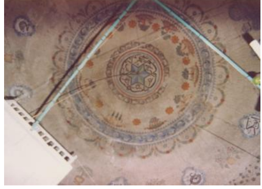
Foto. 50: Afyon, Sandıklı, Ulu Camii, harim, kubbe, restorasyon öncesi durumu (V.G.M.'den)
