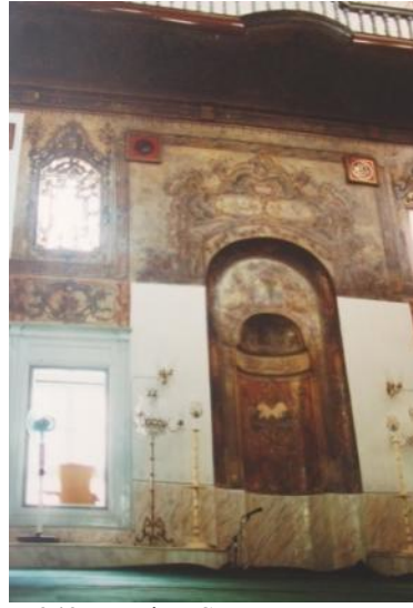
Foto. 343: Manisa, Soma Hızır Bey (Çarşı) Camii, iç mekan, mihrap, detay, 2009 öncesi durumu, (V.G.M'den)
