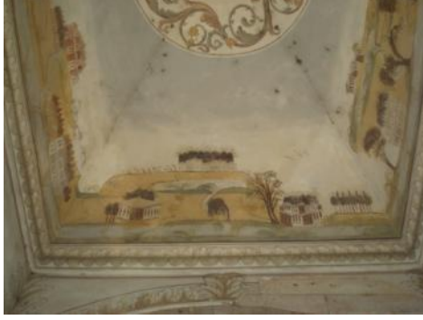
Foto. 639: Edirne Meriç Köprüsü Tarih Köşkü, tonoz, kuzey iç kısım detay
