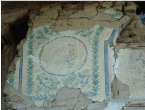
Foto. 114: Denizli, Çivril, Savran Köyü Camii, son cemaat yeri, güney cephe, detay
