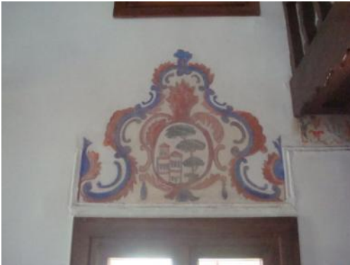
Foto. 96: Aydın, Koçarlı, Cincin Köyü Camii, batı duvar, orta (alt) pencere alınlık, detay
