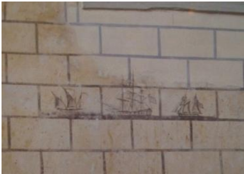
Foto. 377: İzmir, Ödemiş, Birgi Çakırağa Konağı, batı cephe, detay (İ.Kuyulu'dan)
