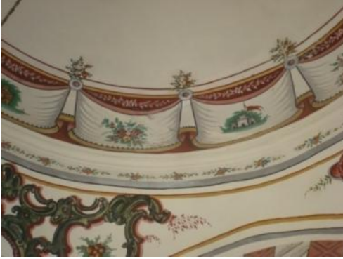
Foto. 202: Manisa (Merkez) Sultan (Valide Mesir) Camii, son cemaat yeri kuzeydoğu kubbe, detay
