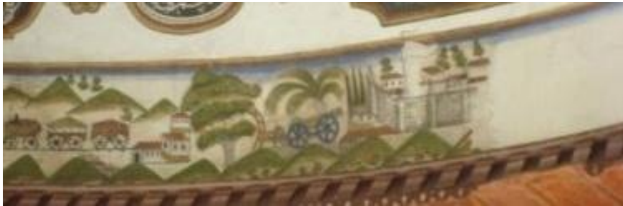
Foto. 701: Amasya (Merkez), II. Bayezid Camii Şadırvanı, kubbe eteği detay
