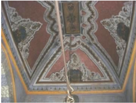
Foto. 515: Yozgat, Çapanoğlu Camii, mahfil, ikinci kat, tonoz detay
