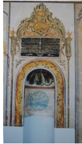
Foto. 313: Manisa, Soma Hızır Bey (Çarşı) Camii, son cemaat yeri, batı revakı güney duvar, mihrap nişi
