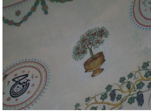
Foto. 56: Afyon, Sandıklı, Ulu Camii, kubbe detay , restorasyon sonrası
