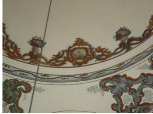
Foto. 199: Manisa (Merkez) Sultan (Valide Mesir) Camii, son cemaat yeri, kubbe, detay
