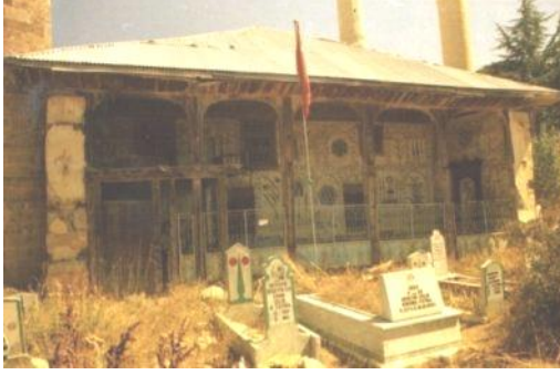
Foto. 493: Konya, Bozkır Hisarlık (Asarlık) Camii, genel görünüş (V.G.M'den)
