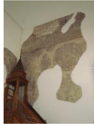
Foto. 623: Edirne Muradiye Camii, iç mekan, batı duvar
