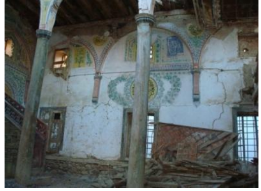
Foto. 122: Denizli, Çivril, Savran Köyü Camii, harim, batı duvar
