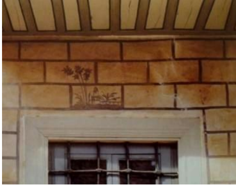
Foto. 375: İzmir, Ödemiş, Birgi Çakırağa Konağı, batı cephe, detay (İ.Kuyulu'dan)
