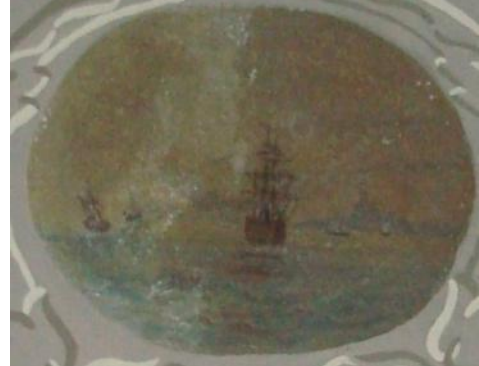
Foto. 593: Edirne Saadet Yardım- Bahattin Ögütmen Evi, iç mekan, zemin kat, kuzeydoğu oda tavan detay
