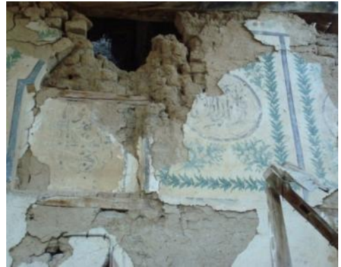
Foto. 115: Denizli, Çivril, Savran Köyü Camii, son cemaat yeri, güney cephe, detay
