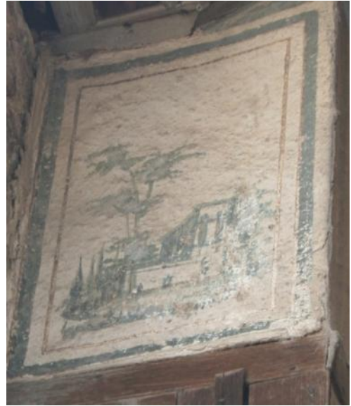
Foto. 436: Manisa, Kula, Kaçıklar Evi, cephedeki çıkmanın çatı ile birleştiği yan yüzey, detay (R.Bozer)
