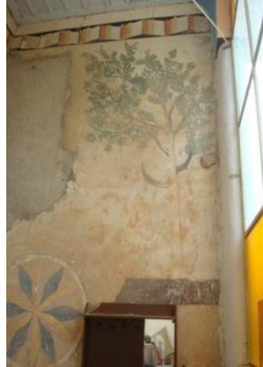
Foto. 42: Afyon, Dazkırı, Kızılören Köyü Camii, son cemaat yeri, batı duvar, detay
