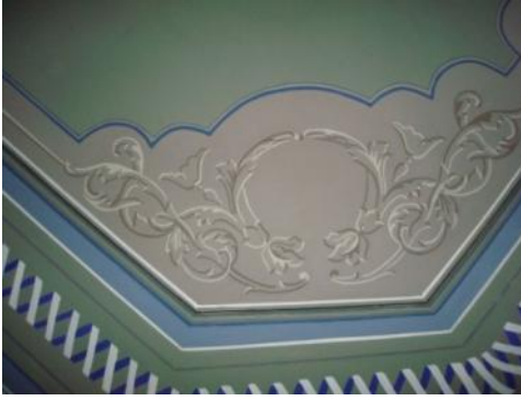
Foto. 592: Edirne Saadet Yardım- Bahattin Ögütmen Evi, iç mekan, zemin kat, kuzeydoğu oda tavan detay
