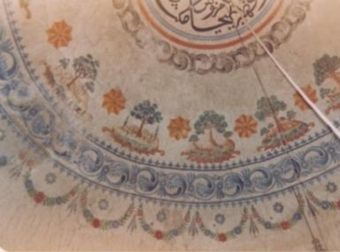
Foto. 59: Afyon, Sandıklı, Ulu Camii, kubbe, restorasyon öncesi (V.G.M.'den)
