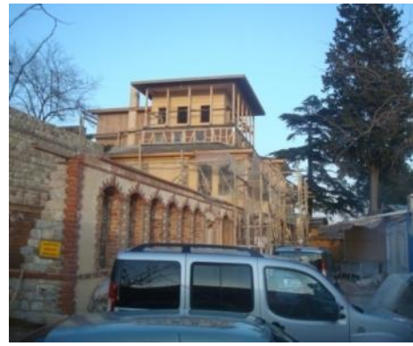
Foto. 617: İzmit Sırrı Paşa Konağı, dıştan genel görünüş
