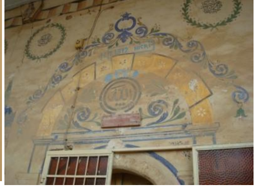
Foto. 38 : Afyon, Dazkırı, Kızılören Köyü Camii, son cemaat yeri, giriş (kitabe)
