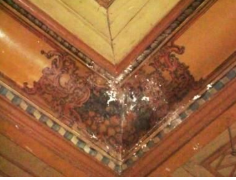
Foto. 232: Manisa, Akhisar, Zeytinliova Kara Osman-oğlu (Hacı Mustafa Ağa) Camii, tavan iç bükey kavisli geçiş kuşağı köşesi, detay
