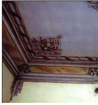
Foto. 861: Gaziantep Nadire Küllükoğlu Evi, iç mekan tavan detay (A.Atalar'dan)
