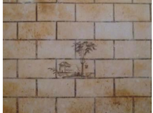
Foto. 376: İzmir, Ödemiş, Birgi Çakırağa Konağı, batı cephe, detay (İ.Kuyulu'dan)
