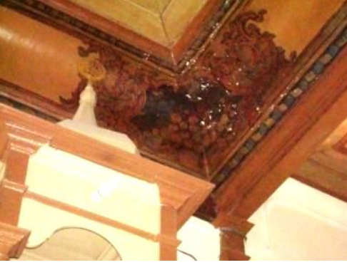
Foto. 234: Manisa, Akhisar, Zeytinliova Kara Osman-oğlu (Hacı Mustafa Ağa) Camii, tavan iç bükey kavisli geçiş kuşağı köşesi, detay
