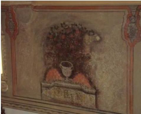
Foto. 72: Aydın, Koçarlı Cihanoğlu Camii, batı duvar detay
