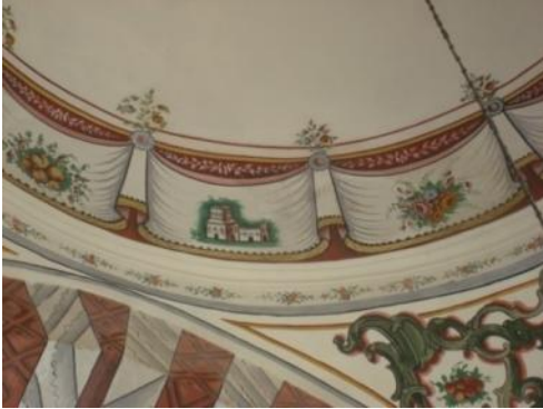
Foto. 204: Manisa (Merkez) Sultan (Valide Mesir) Camii, son cemaat yeri, kuzeydoğu kubbe, detay
