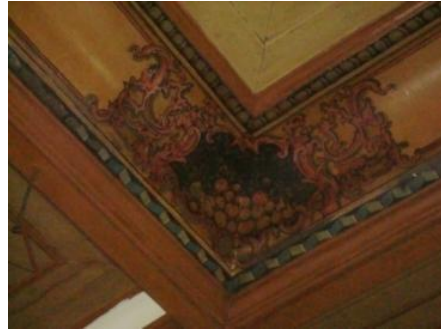
Foto. 231: Manisa, Akhisar, Zeytinliova Kara Osman-oğlu (Hacı Mustafa Ağa) Camii, tavan iç bükey kavisli geçiş kuşağı köşesi, detay
