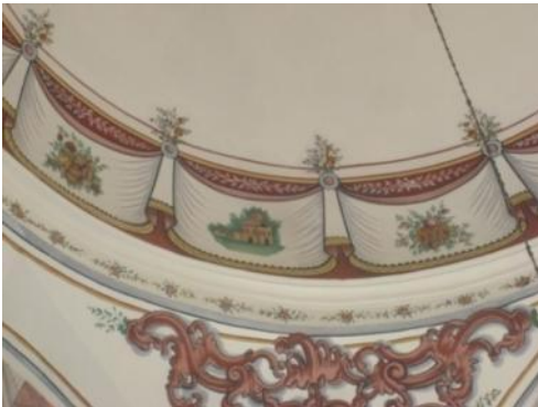
Foto. 206: Manisa (Merkez) Sultan (Valide Mesir) Camii, son cemaat yeri, kuzeydoğu kubbe, detay
