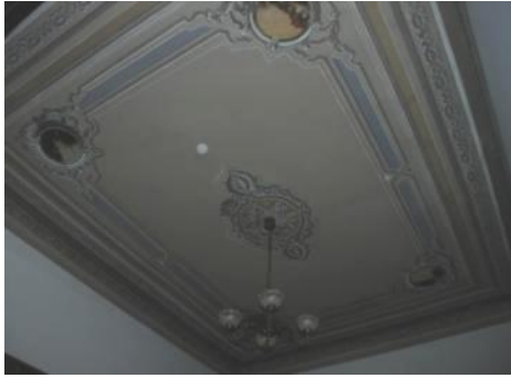
Foto. 610: Edirne İlhan Koman Evi, iç mekan, giriş Sofası'nın kuzeyindeki oda tavan (Yavuz Günel)
