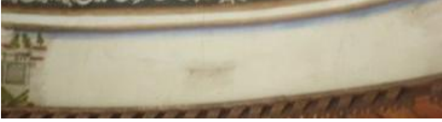
Foto. 702: Amasya (Merkez), II. Bayezid Camii Şadırvanı, kubbe eteği detay
