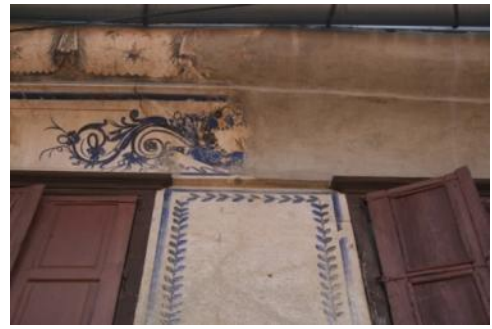
Foto. 432: Manisa, Kula, Beyazoğlu Evi, kuzey cephe, pencere açıklıkları aralarındaki duvar yüzeyleri, detay (R.Bozer)
