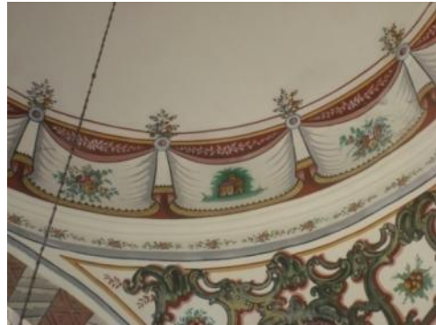
Foto. 201: Manisa (Merkez) Sultan (Valide Mesir) Camii, son cemaat yeri, kuzeydoğu kubbe, detay
