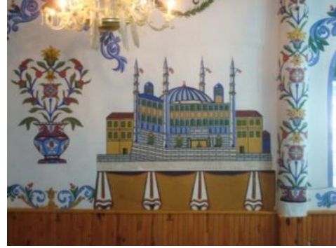
Foto. 34 : Afyon, Dazkırı, Çiftlik Köyü Camii, harim, doğu duvar kuzey yönü, restorasyon sonrası
