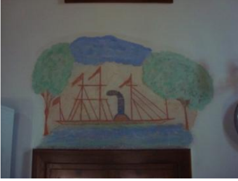
Foto. 88: Aydın, Koçarlı, Cincin Köyü Camii, doğu duvar, orta pencere alınlık detay
