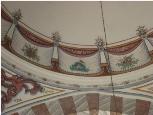
Foto. 200: Manisa (Merkez) Sultan (Valide Mesir) Camii, son cemaat yeri, kuzeydoğu kubbe, detay
