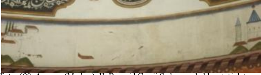
Foto. 698: Amasya (Merkez), II. Bayezid Camii Şadırvanı, kubbe eteği detay
