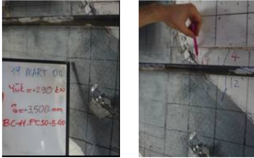
Şekil A.27 : Numune N2'nin \pm 3.5 mm yerdeğiştirme adımındaki hasar durumu.
