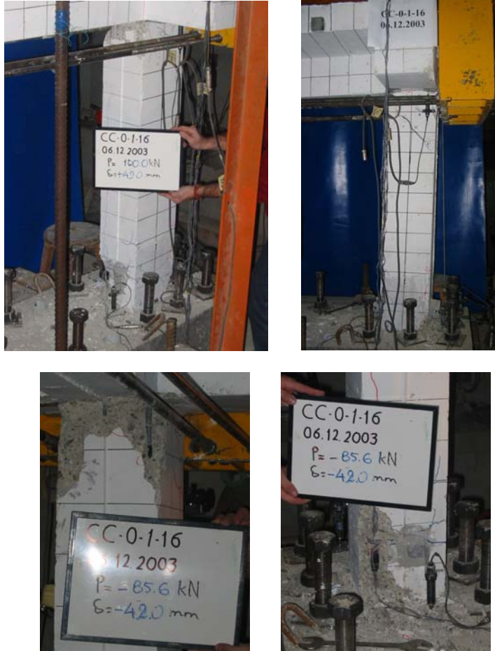
Şekil A.23 : ‘Dolgu Duvarsız Numune 2’nin \pm 42 mm yerdeğiştirme adımındaki hasar durumu.
