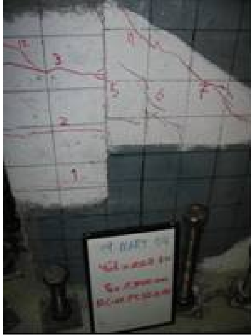
Şekil 4.23 : Numune N2'nin \pm 2.8 mm yerdeğiřtirme adımındaki hasar durumu.
