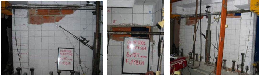
Şekil 4.21 : Numune N1'in \pm 10.5 mm yerdeğiştirme adımındaki hasar durumu.
