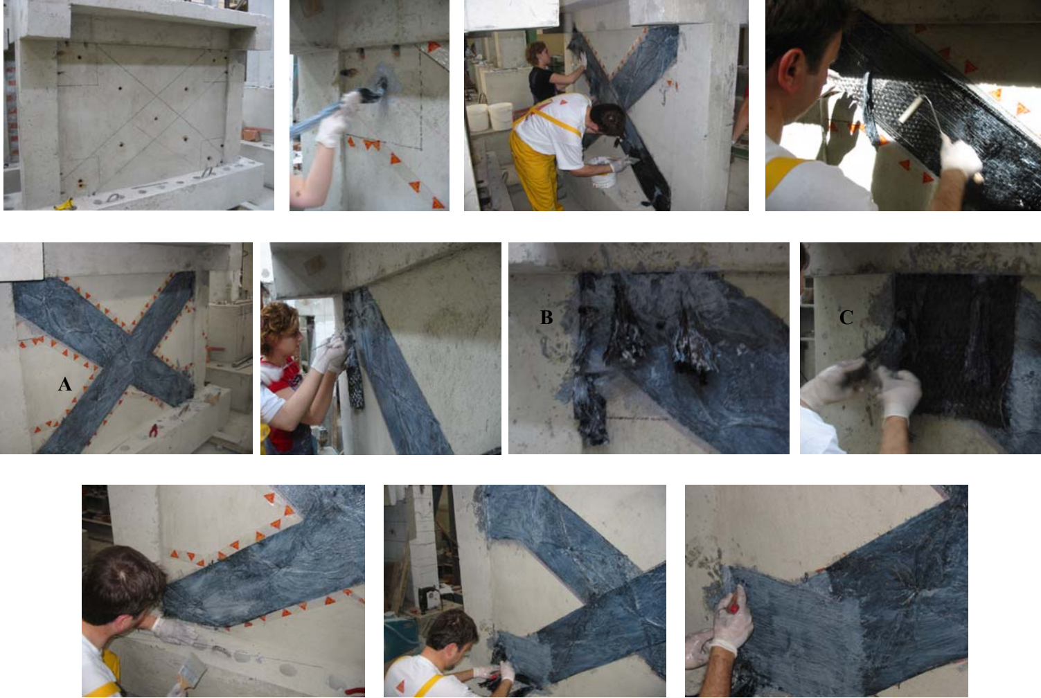
Şekil 4.5 : N3 numunesinin CFRP ile güçlendirilme aşamaları.
