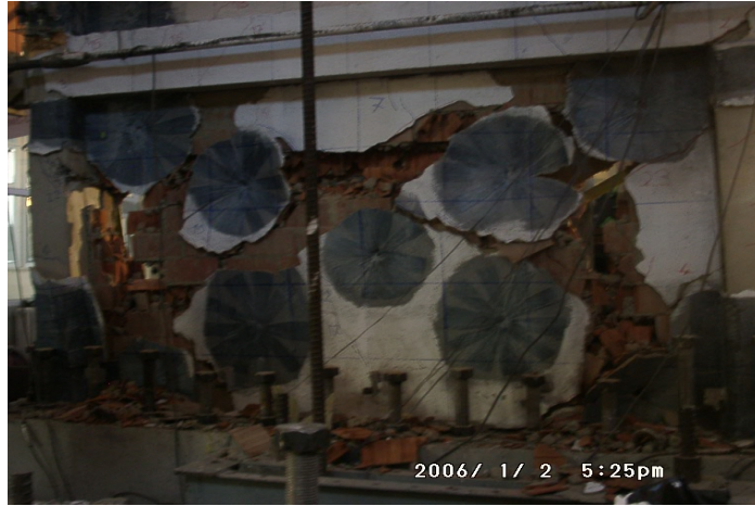
Şekil 5.21 : IL-C2'nin hasar durumu.
