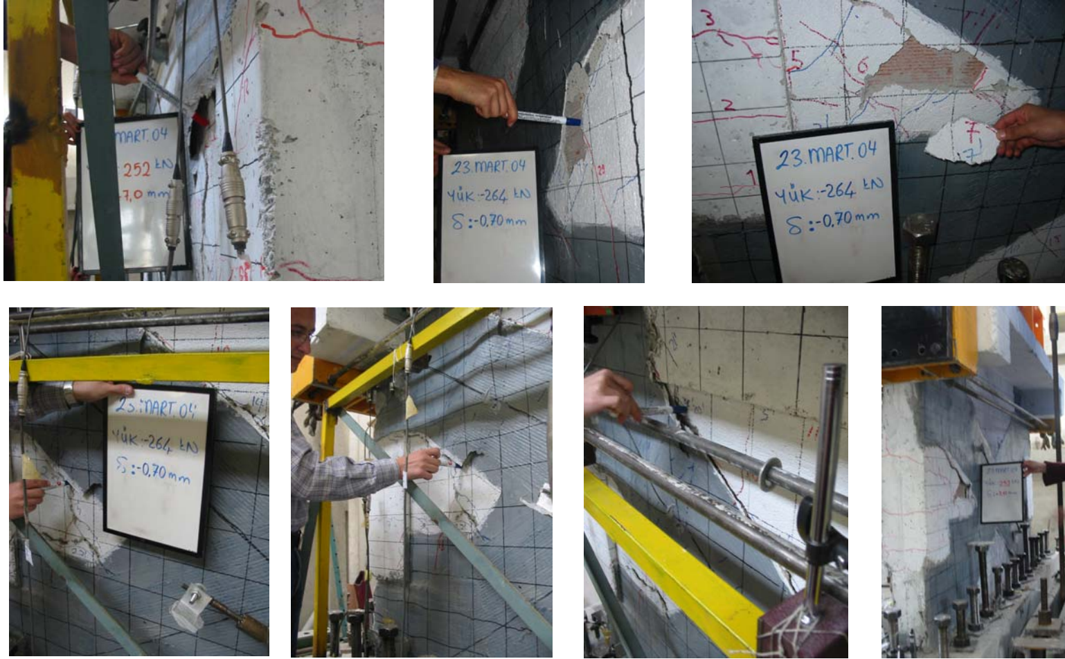
Şekil A.29 : Numune N2'nin \pm 7 mm yerdeğiştirme adımındaki hasar durumu.
