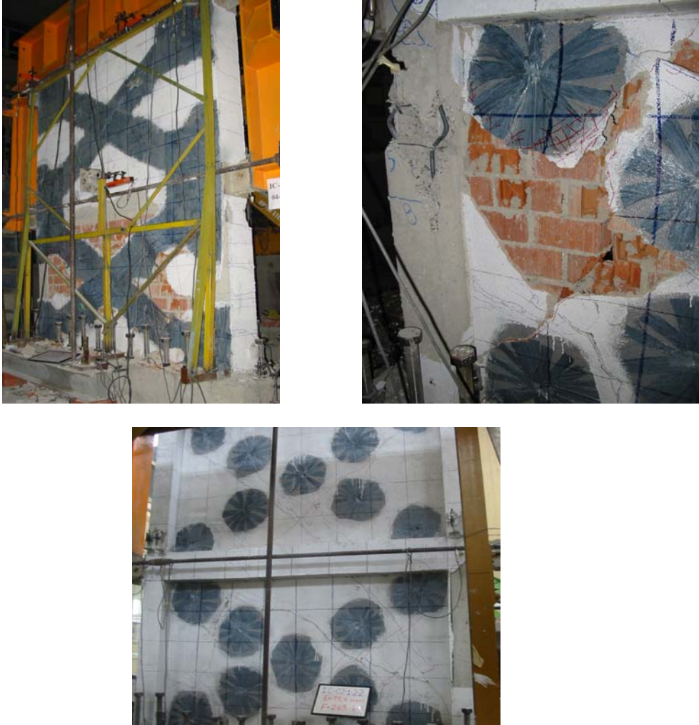
Şekil 5.19 : IC-C2'nin hasar durumu.
