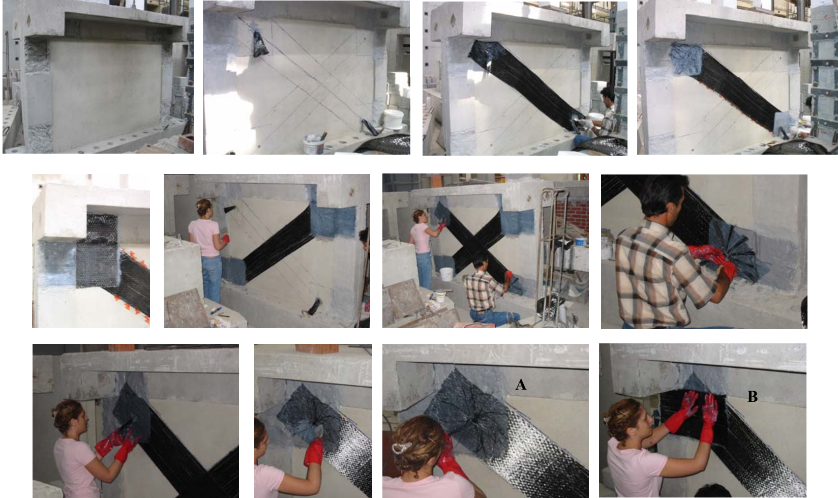
Şekil 4.6 : N4 numunesinin CFRP ile güçlendirilme aşamaları.
