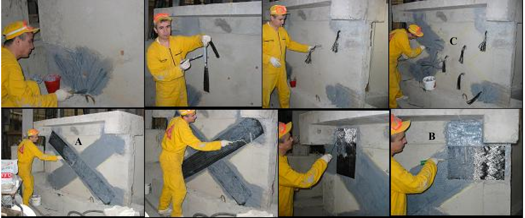
Şekil 4.4 : N2 numunesinin CFRP ile güçlendirilme aşamaları.
