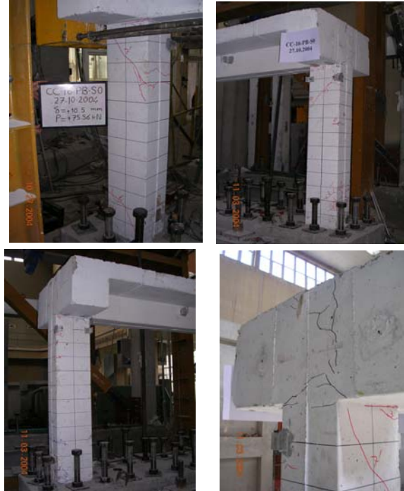
Şekil A.18 : ‘Dolgu Duvarsız Numune 1’in \pm 10.5 \text{ mm} yerdeğiştirme adımındaki hasar durumu.
