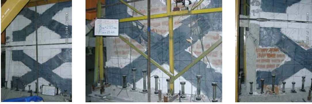
Şekil 5.14 : IC-C1'in hasar durumu.
