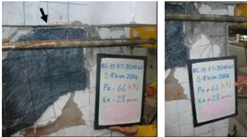
Şekil 4.39 : Numune N3'ün +28 mm yerdeğiştirme adımının ikinci itme çevrimindeki hasar durumu.
