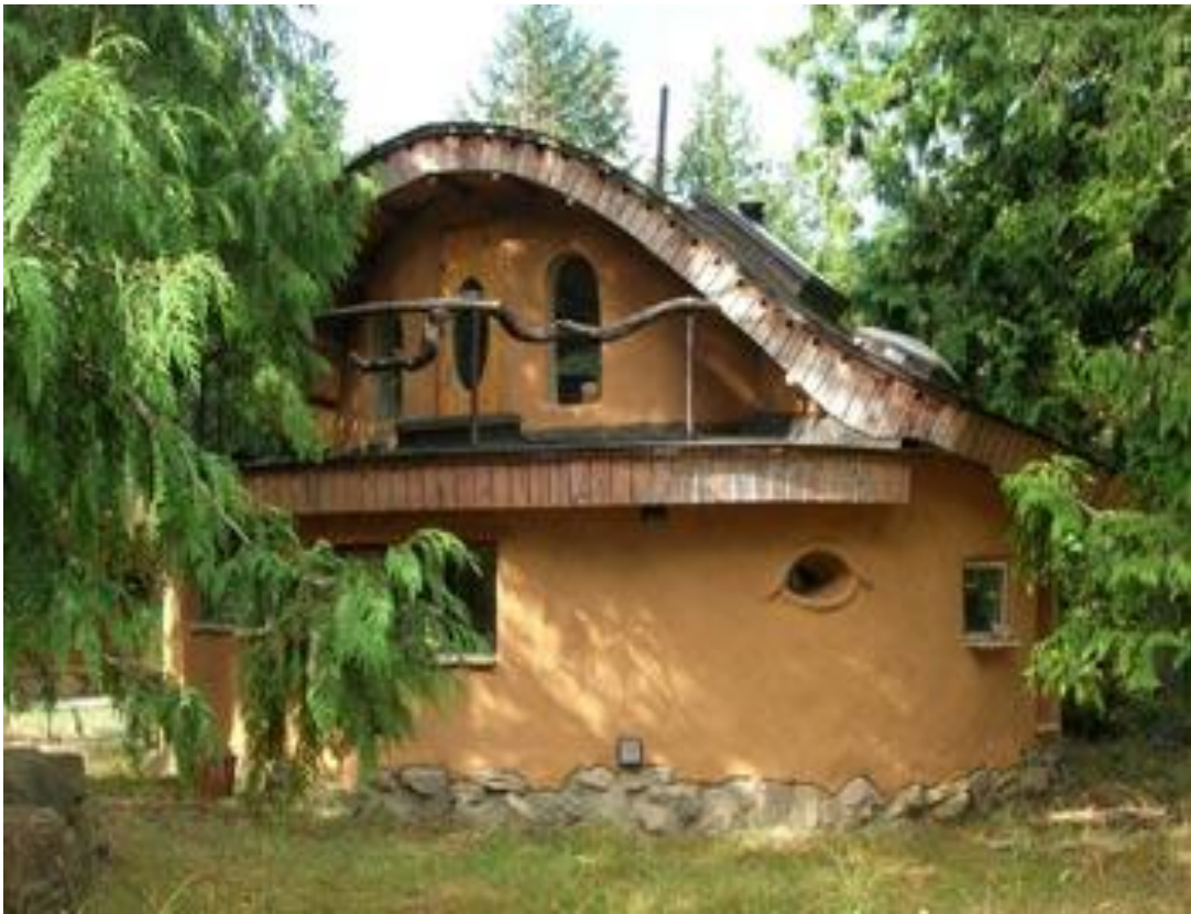
Şekil 2.24 : Püskürtme ile uygulanan toprak yapılar [28].
