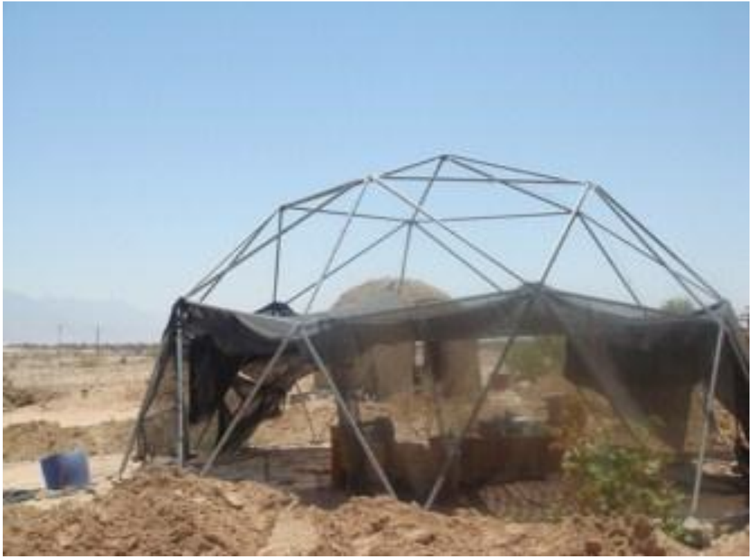
Şekil 2.22 : Püskürtme ile uygulanan toprak yapılar [28].
