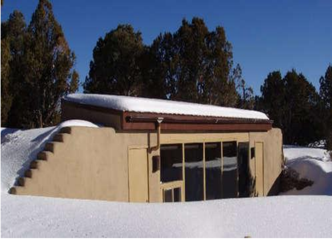
Şekil 2.23 : Püskürtme ile uygulanan toprak yapılar [28].
