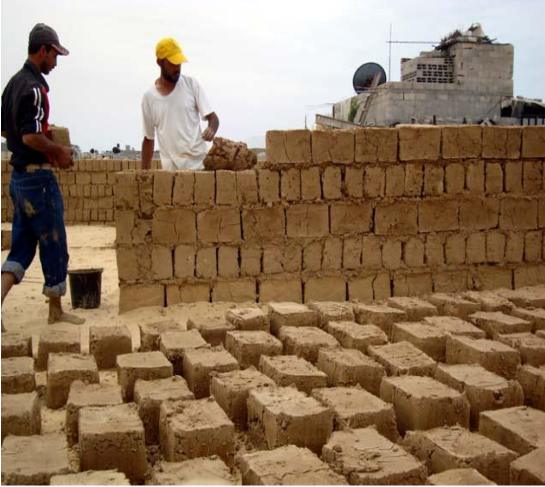
Şekil 2.19 : Tuğla örme tekniği (blok kerpiç) [27].
