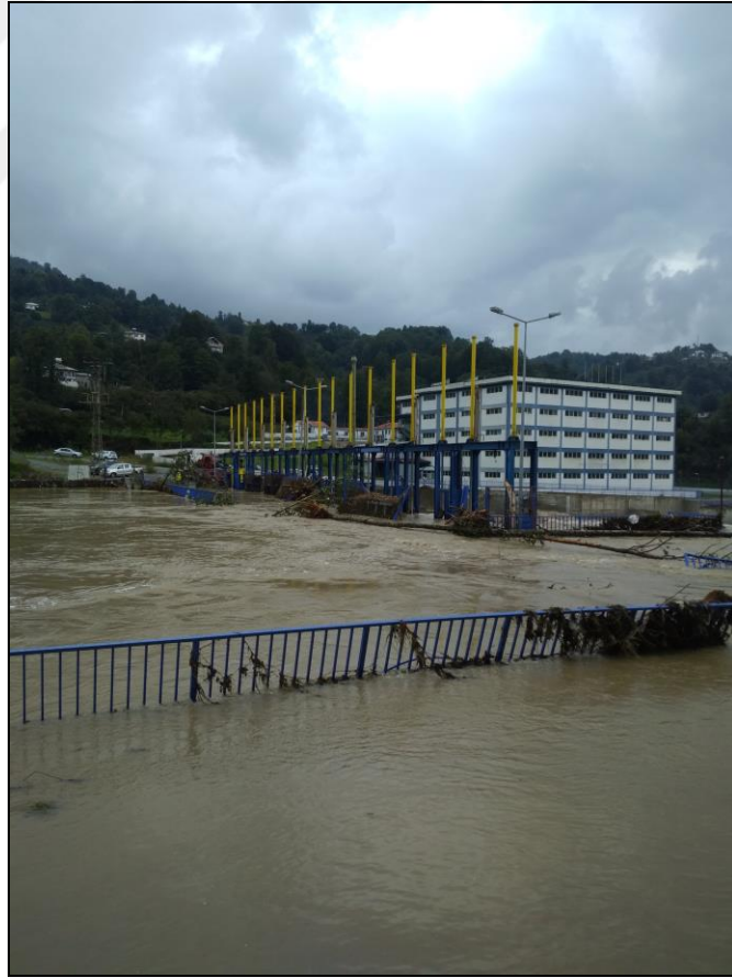
Şekil 4.6: 29 Eylül 2019 tarihinde meydana gelen sel ve taşkında, KAVAK HES'in Orçi Deresi üzerindeki regülatörü zarar görmüştür (Foto: N. D. Uyanık, 2019).
