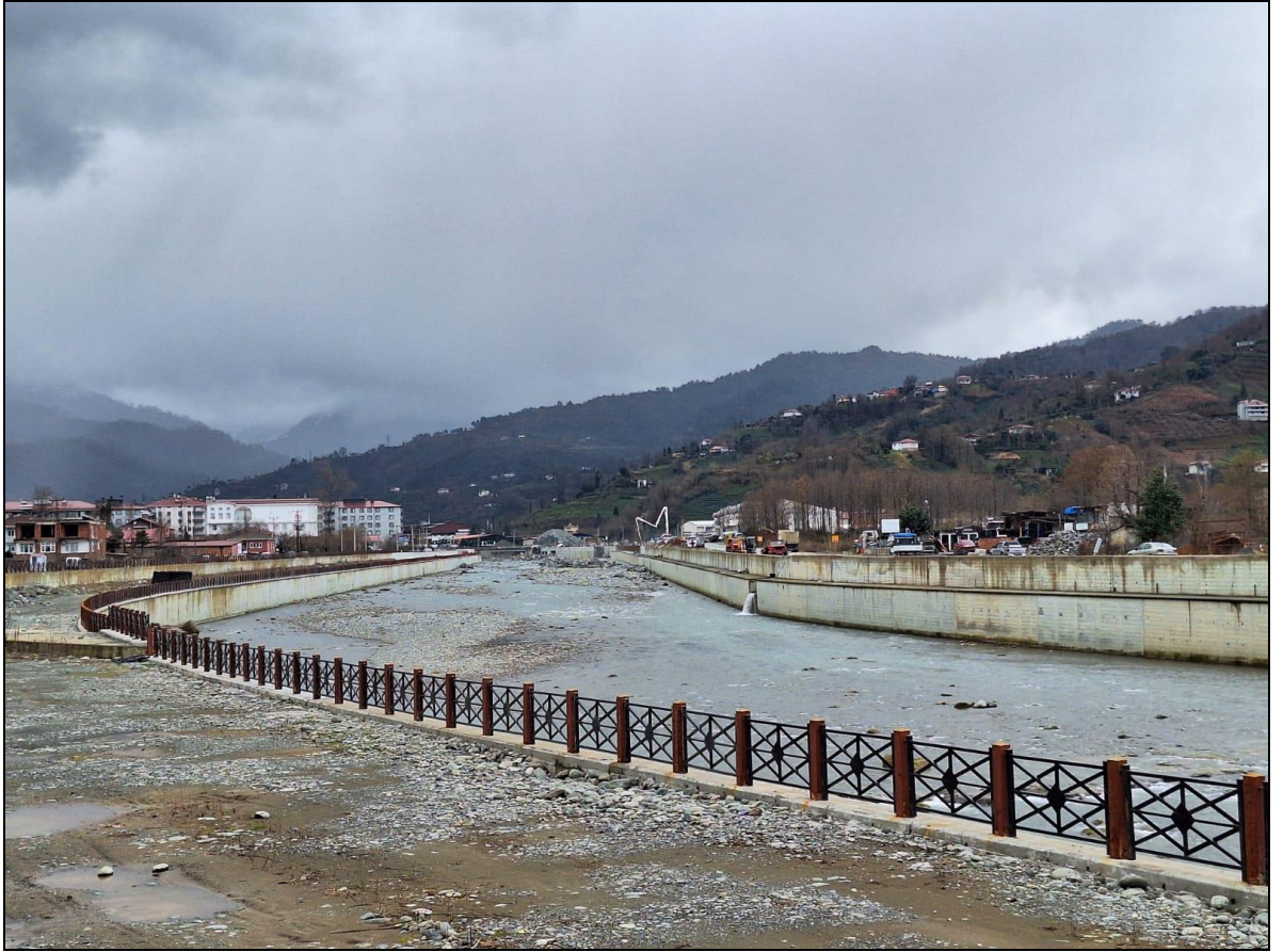
Şekil 5.5: Kapisre Deresi üzerinde yapımı tamamlanan beton ıslah duvarları (Foto: A. B. Uyanık, 2025).
