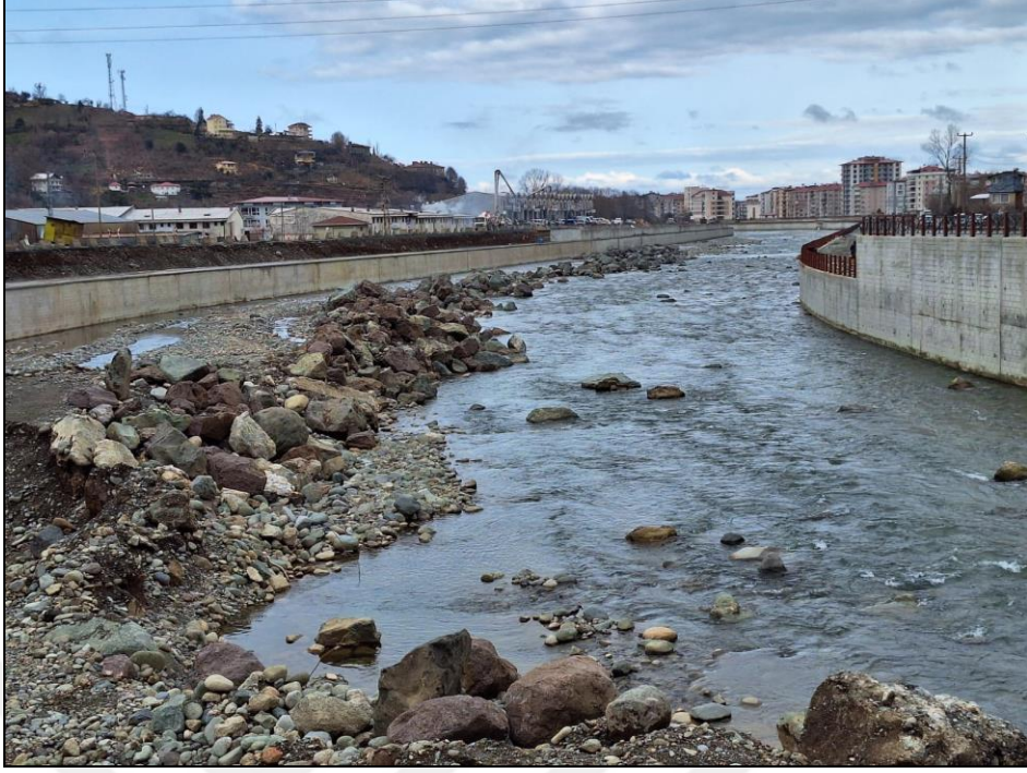
Şekil 5.6: Kapisre Deresi üzerinde inşası devam eden beton ıslah duvarları (Foto: A. B. Uyanık, 2025).
