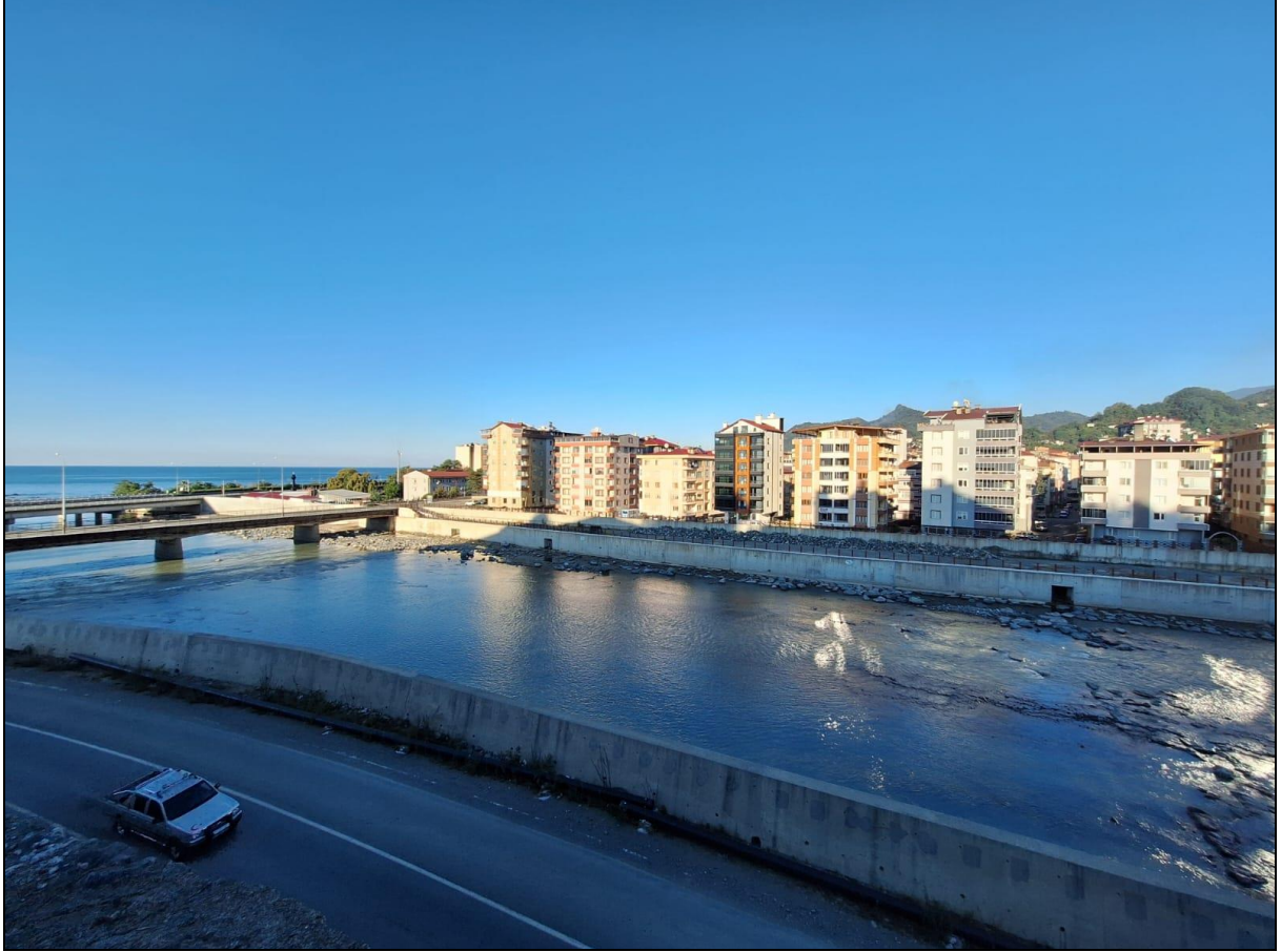
Şekil 5.3: Boğaziçi mahallesinin Kale mevkiinden görünümü (Foto: N. D. Uyanık, 2024).
