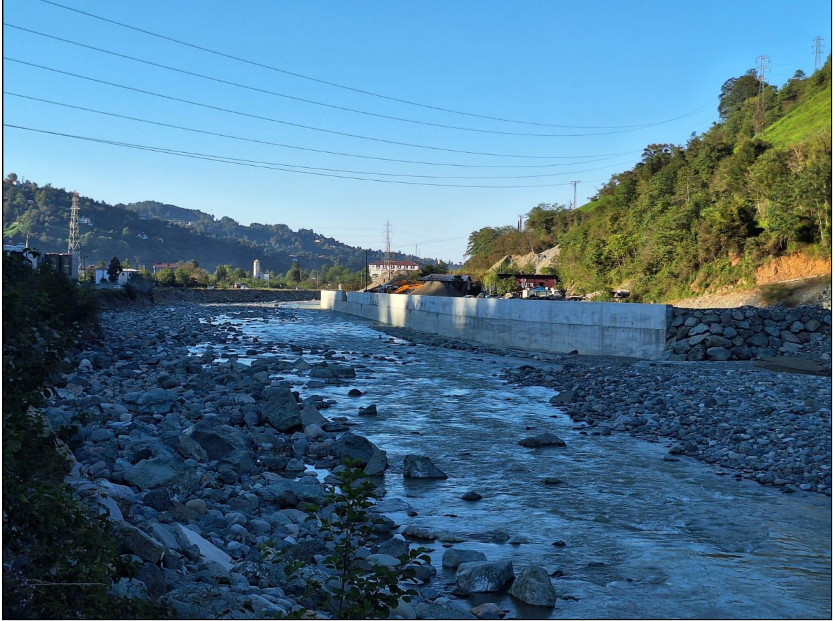
Şekil 5.4: Kapisre Deresi üzerinde yer alan bir tesise arazi kazandırmak amacıyla dereyi daraltarak kurulan beton istinat duvarları (Foto: N. D. Uyanık, 2024).
