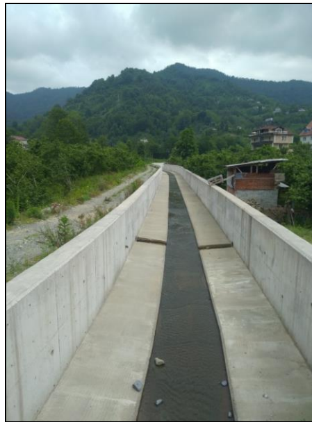
Şekil 5.7: Cumhuriyet Mahallesi'nde yer alan beton dere istinat duvarları (Foto: N. D. Uyanık, 2024).
