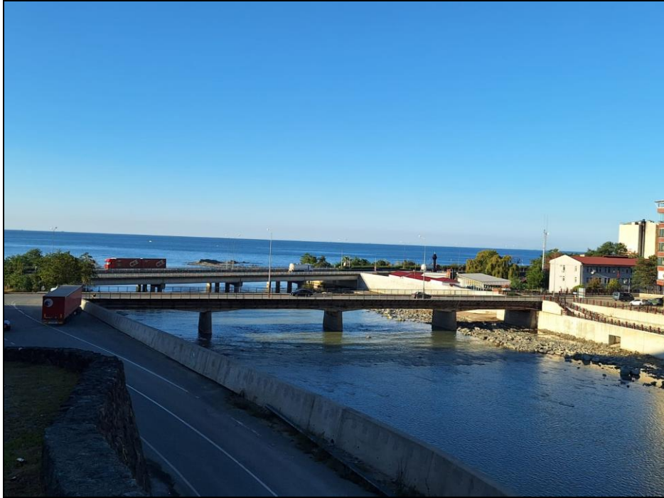
Şekil 5.1: Kapisre Deresi üzerinden geçen Kapisre Köprüsü ve Karadeniz Sahil Yolu (Foto: N. D. Uyanık, 2024).
