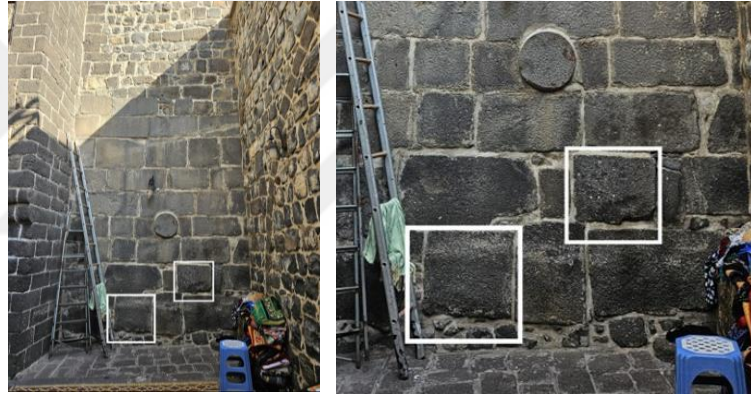
Şekil 4.68 Hz. Süleyman (Kale) Cami’de Schmidt çekici ile sertlik değeri belirlenen 30 ve 31 numaralı bazalt taşları (2024)
