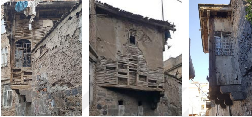
Şekil 3.22 Cumbaların ahşap elemanlarındaki yapısal sorunlar, renk değişimleri ve dokusal hasarlar (2024)
