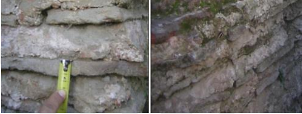
Şekil 3.1 Gizli duvar tekniği ile örülmüş duvar (Yüzer, 2015)
