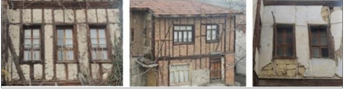
Şekil 3.7 Ahşap çerçeveye sahip yapının taş, tuğla ve kerpiç ile hımış dolgusu (Güneş, 2014)
