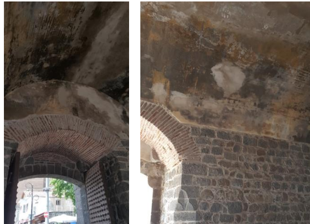
Şekil 3.27 Tonozlarda meydana gelen biyolojik oluşumlar (2024)
