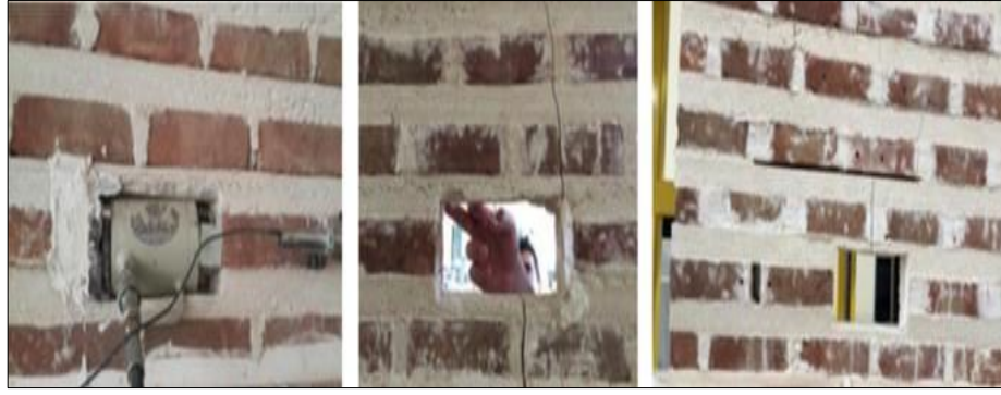
Şekil 3.74 Yerinde kayma deneyinde oluşması istenmeyen çatlaklar (Yüzer, 2015)
