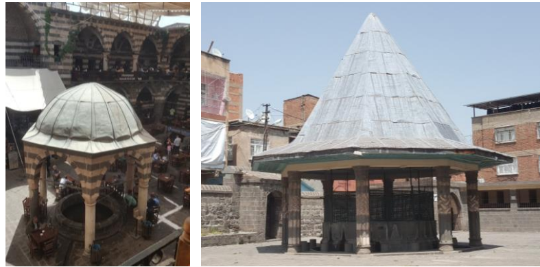
Şekil 3.23 Tarihi yapılarda şadırvanda metal malzemenin kullanımı (2024)
