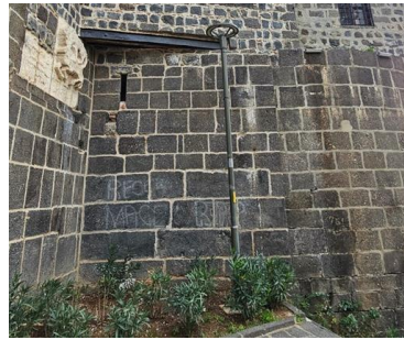
Şekil 4.53 Hz. Süleyman (Kale) Cami’nin batı girişinde bulunan burç duvarlarındaki yazılar (2024)
