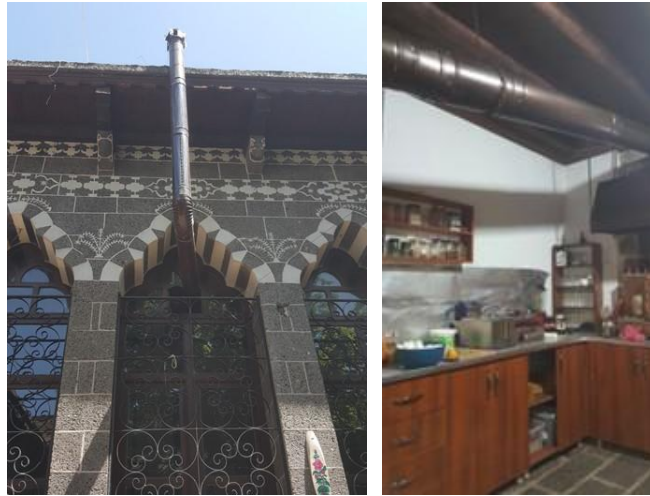
Şekil 3.29 Hatalı ve niteliksiz uygulamalar ile geleneksel evin yeniden işlevlendirilmesi (2024)
