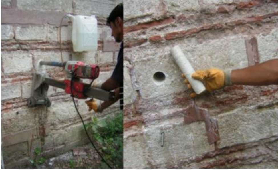
Şekil 3.77 Yapıdan karot alma uygulaması ve elde edilen numune (Yüzer ve Ekşi Akbulut)
