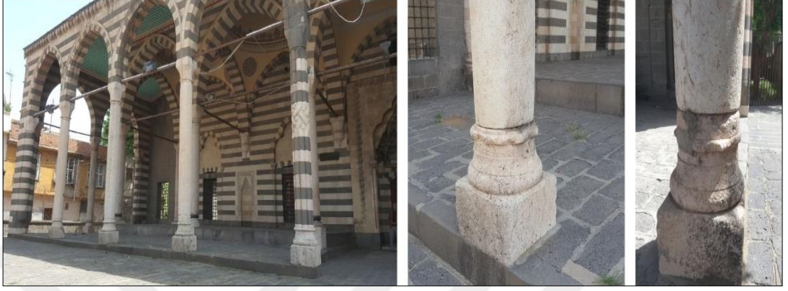
Şekil 3.16 Diyarbakir Behram Paşa Cami sütunlarında eksen kayması sorunu (Budak ve Işık , 2023)
