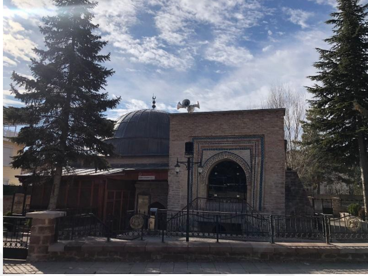
Fotoğraf-35: Cemal Ali Dede (Turut) Türbesi Dış Cephe Görünümü (Aybike Büşra ÇAKIR Kişisel Arşiv, 2023).
