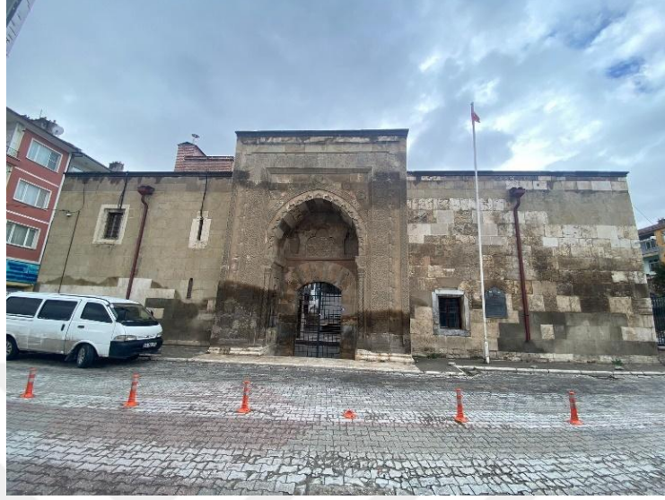
Fotoğraf-13: Sırçalı Bedreddin Muslih Türbesi Dış Cephe Görünümü (Aybike Büşra ÇAKIR Kişisel Arşiv, 2023).
