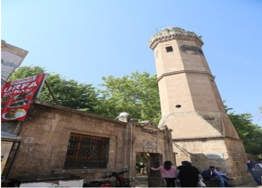
Şekil 3.18. Sürvey çalışması yürütülen Hasanpaşa Cami'sinin genel görüntüsü
