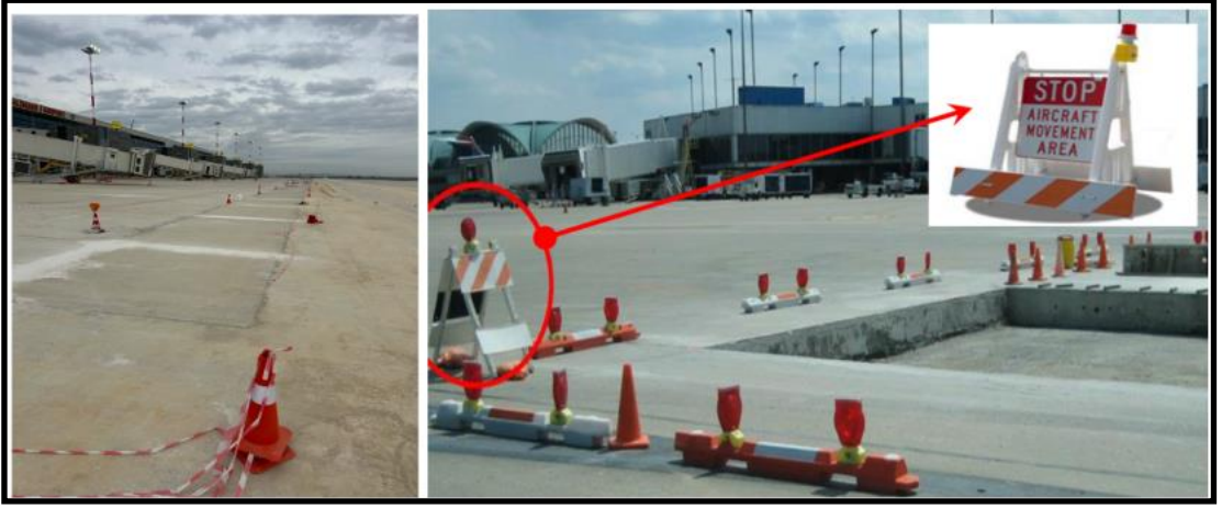
Görsel 6.18. Sabit cisimlere işaretleyici uygulama örnekleri (DHMI, 2020)
