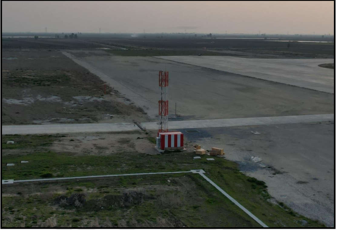
Görsel 7.5. Çukurova Uluslararası Havalimanı glide path sabit cisimleri renklerle işaretleme uygulama örnekleri (Yazar tarafından oluşturulmuştur.)
