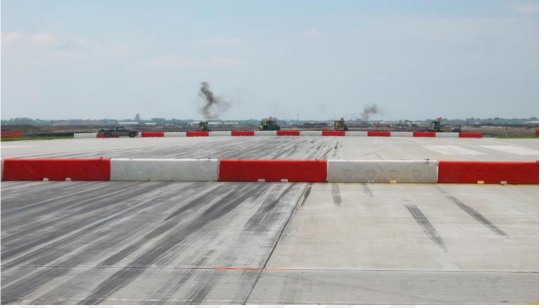
Görsel 7.11. Sabit Cisimleri işaretleyiciler ile işaretleme uygulama örneği (DHMİ, 2020)
