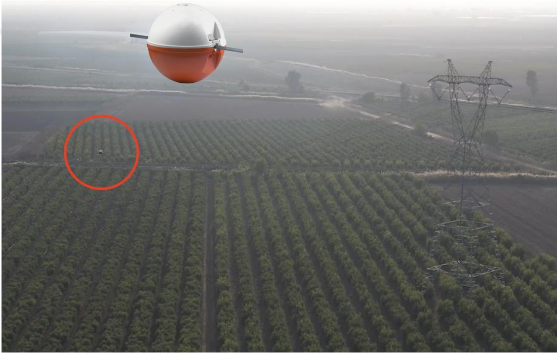
Görsel 7.18. Çukurova Uluslararası Havalimanı 03 yaklaşma pisti üstten geçen kablolar, teller vb. ve destekleyici kuleleri ikaz küreleri ile işaretleme uygulama örnekleri (Yazar tarafından oluşturulmuştur)
