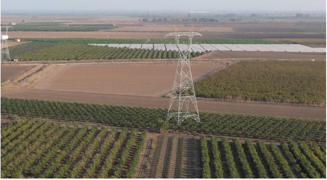
Görsel 7.19. Çukurova Uluslararası Havalimanı 03 yaklaşma pisti üstten geçen kablolar, teller vb. ve destekleyici kuleleri ikaz küreleri ile işaretleme uygulama örnekleri (Yazar tarafından oluşturulmuştur)
