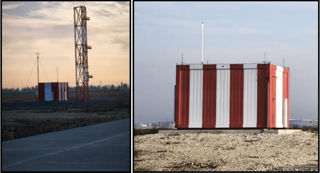
Görsel 7.6. Çukurova Uluslararası Havalimanı sabit cisimleri renklerle işaretleme uygulama örnekleri (Yazar tarafından oluşturulmuştur.)
