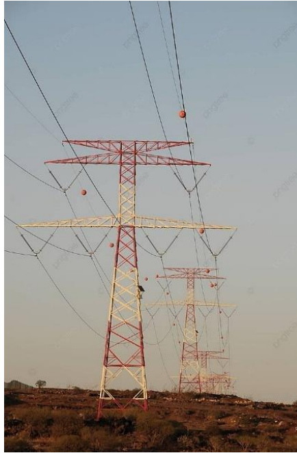
Görsel 7.17. Üstten geçen kablolar, teller vb. ve destekleyici kuleleri renklerle boyama uygulama örnekleri (DHMI, 2020)
