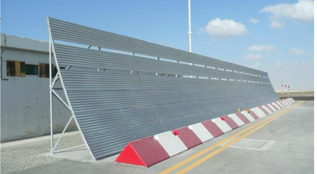
Görsel 7.12. Sabit cisimleri işaretleyiciler ile işaretleme uygulamaları (DHMİ, 2020)
