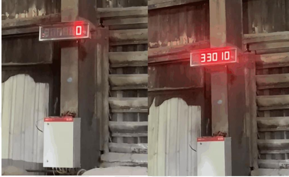
Şekil 5.11. Vagon tartım sistemi ağırlık ölçümü.
