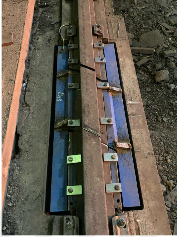
Şekil 5.4. Vagon tartım sistemi modül yerleşim.
