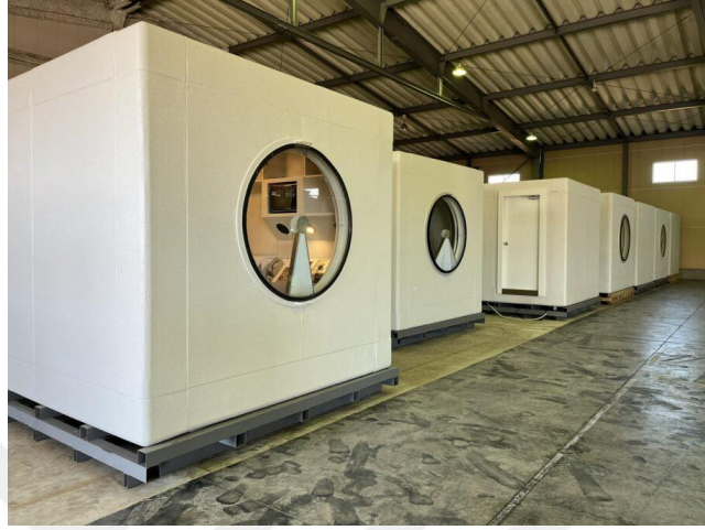
Şekil 3.38: Nakagin kapsüllerinin strüktürden ayrılarak bir atölyede konaklama amacıyla restore edilmek üzere saklanması (Yoshida, 28 Mayıs, 2023)
