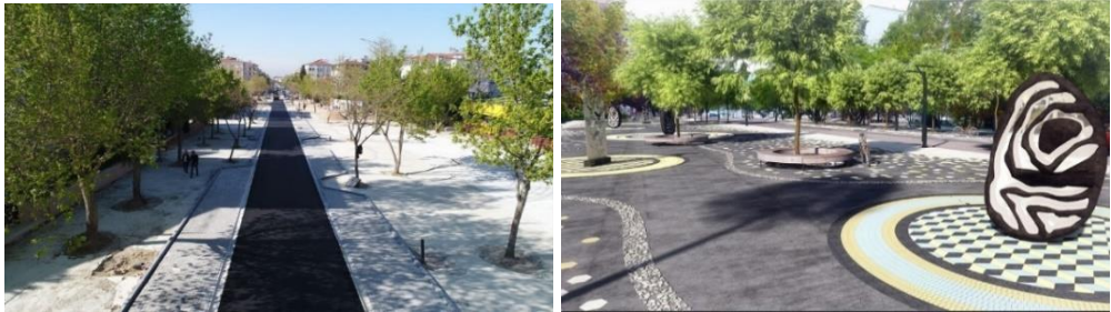
Şekil 4.14 Çamlık Bulvarı’nda peyzaj düzenlemesi ve altyapı yenileme çalışmaları 67
