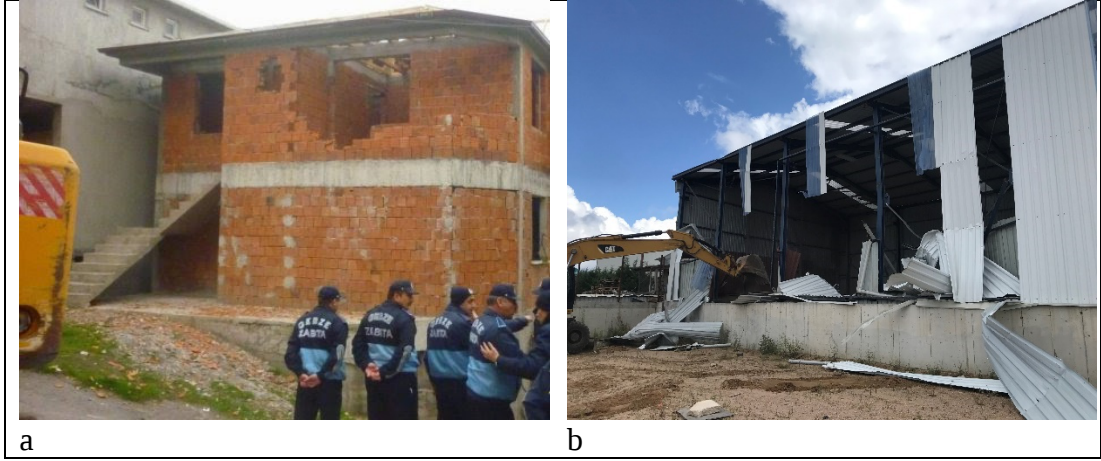
Şekil 4.11: Kaçak Yapılar ve Durumu Belirsiz Sanayi Yapıları [ www.haber3.com & www.ozgurkocaeli.com.tr ].
