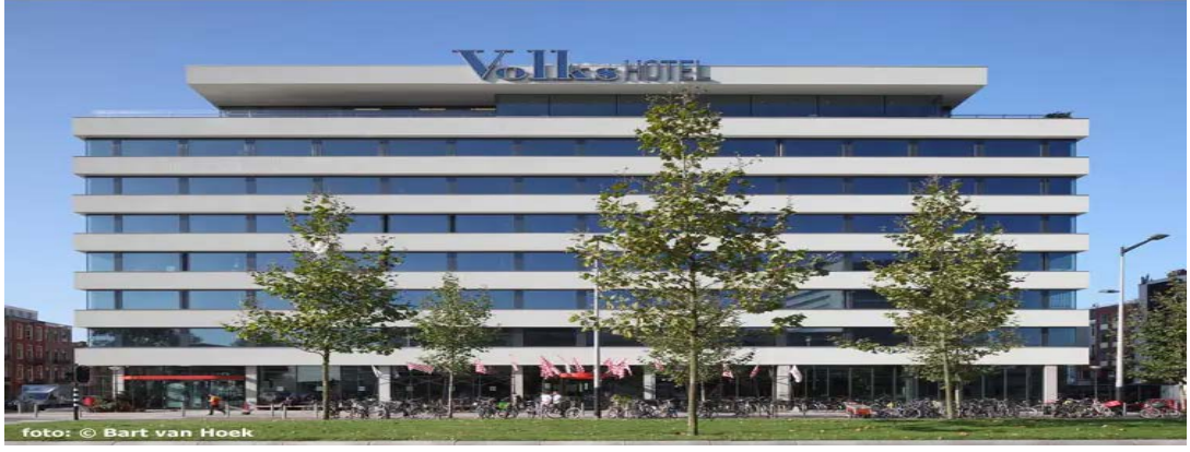
Şekil 2.6: Volkskrant Ofis Binası [ www.architectuur.org ].
