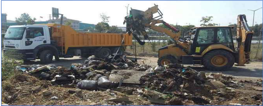
Şekil 4.10: Kaçak Atık Depolama Alanları [ www.cagdaskocaeli.com.tr ].
