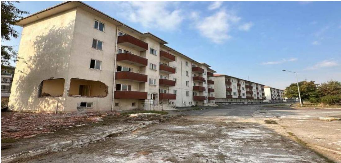
Şekil 4.13: Donanma Komutanlığı Lojmanları: Durumu Belirsiz Arazi [ www.ozgurkocaeli.com.tr ].
