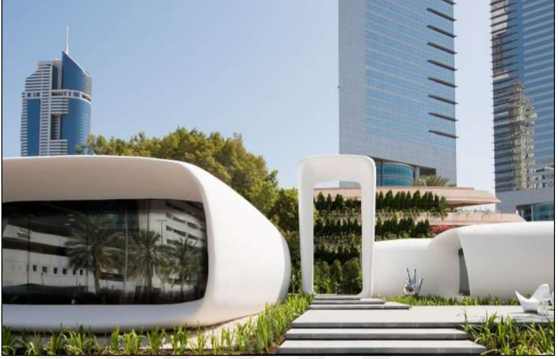
Şekil 1.5. 3B yazıcı kullanılarak inşa edilen ilk ofis binası dış görünüm (Anonim, 2024b)
