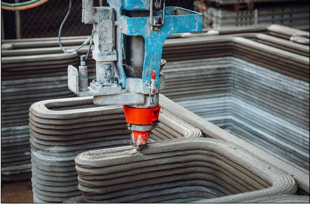
Şekil 1.3. 3B yazıcı ile şekillendirilen beton duvarlar (Anonim, 2024e)
