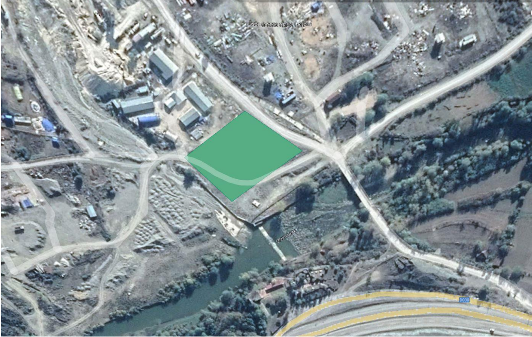
Şekil 3.3 Hanönü Güneş Enerji Santrali Kurulum Alanı
