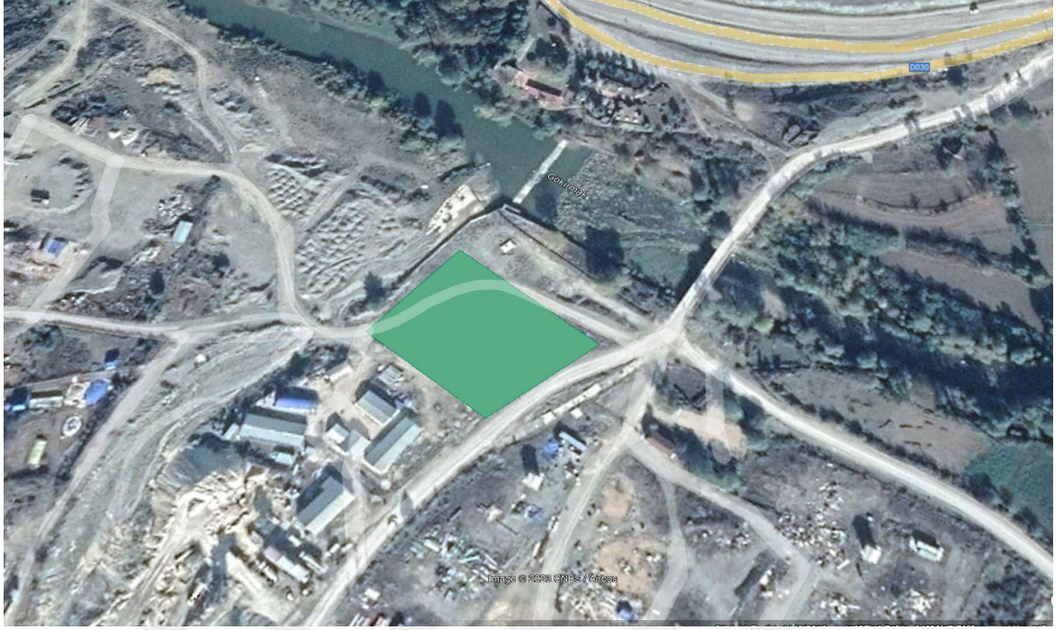
Şekil 4.1 Hanönü (Kastamonu) Güneş Enerji Santrali Kurulum Alanı
