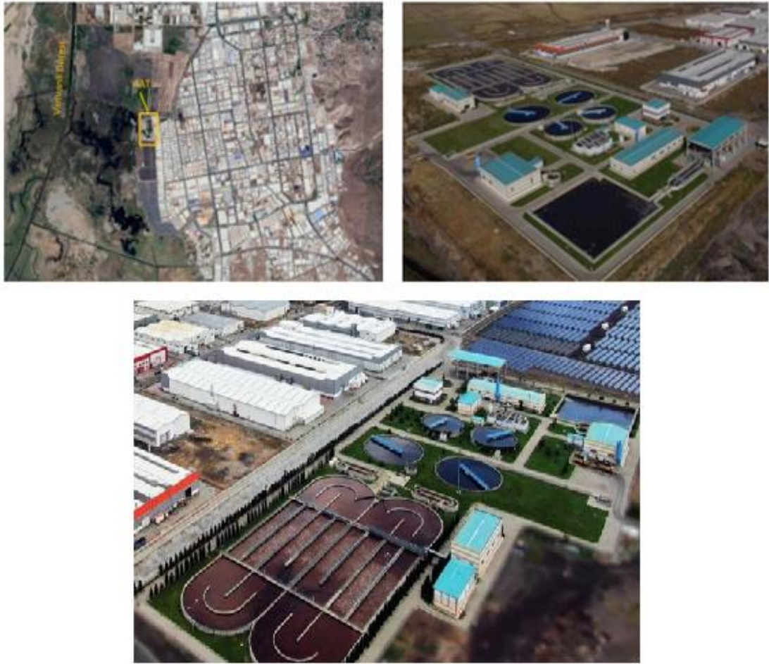
Şekil 9. KOSB Atıksu Arıtma Tesisi
