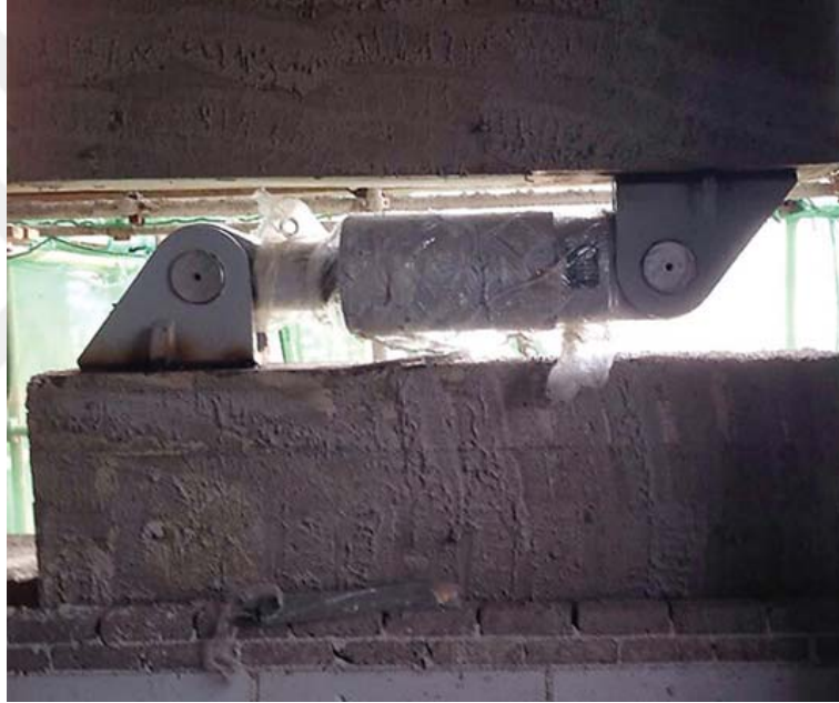
Şekil 3.30. Viskos Sönümleyicinin Yapıya Yerleşimi
