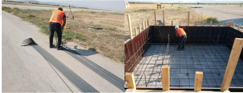
Şekil 2.45: Pist Sıfır Noktasında Demir-Donatı İmalatı
