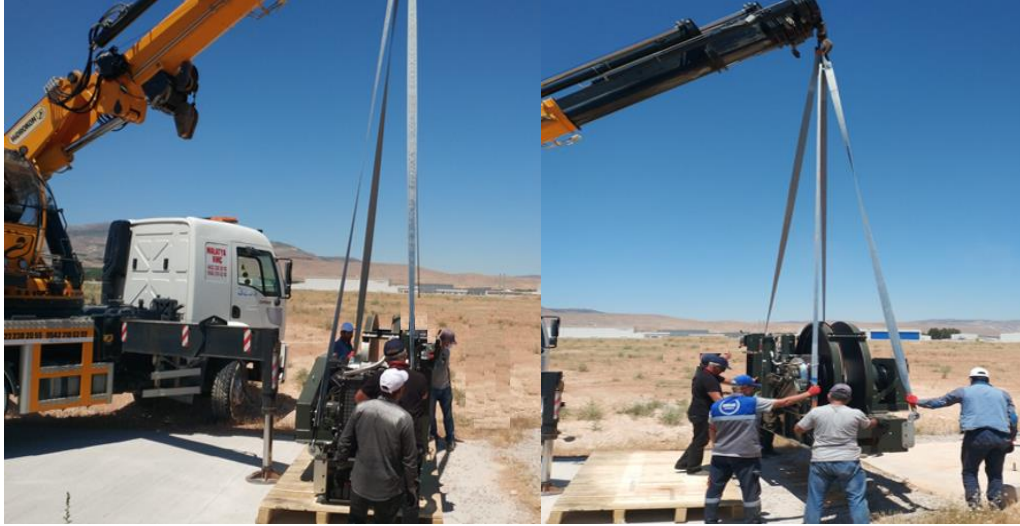
Şekil 2.52: Enerji Emici Kaide Montajı
