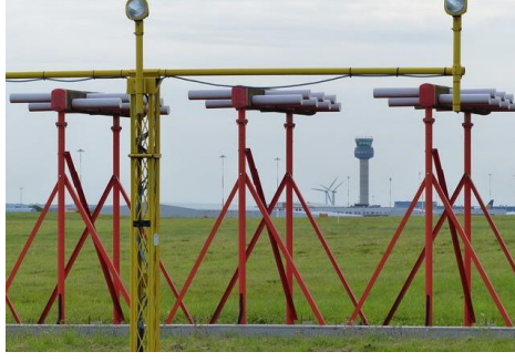
Şekil 2.42: ILS Sistemleri (Yer Antenleri)
