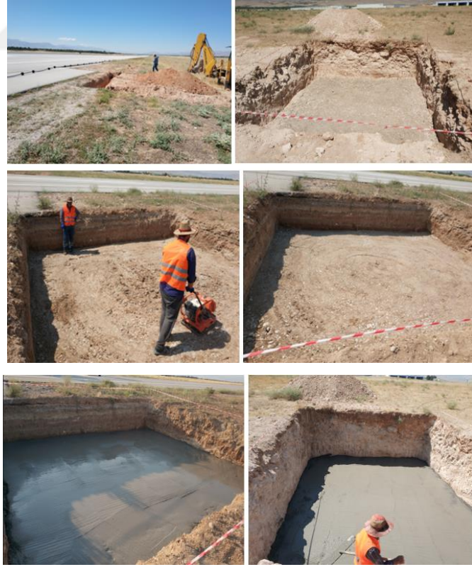
Şekil 2.43: UDS Kaide Yapım Aşamaları
