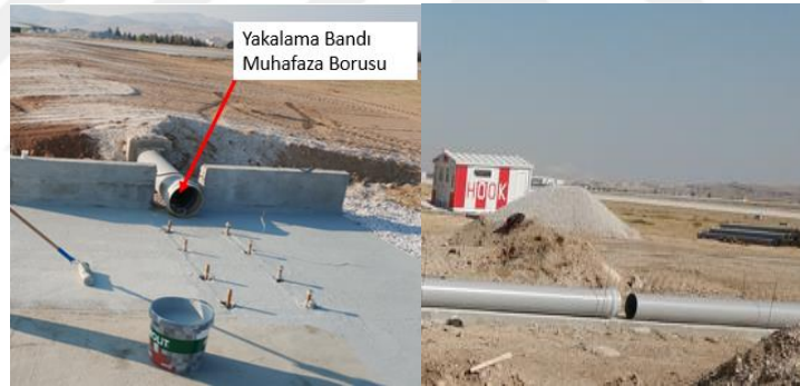
Şekil 2.12: Muhafaza Boruları Pist Yerleşimi
