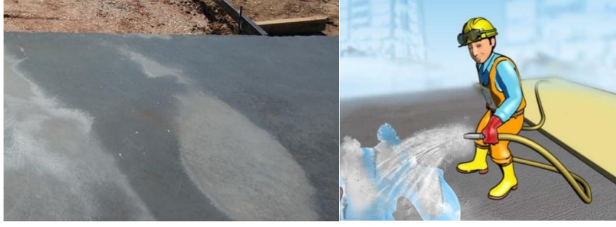
Şekil 2.51: Beton Sulama İşlemi
