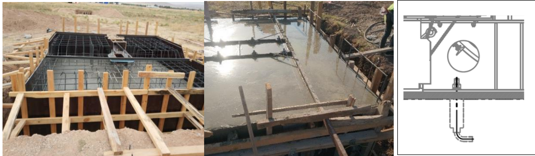
Şekil 2.48: Pist Kenar Makarası ve Enerji Emici Kaide Şablonları
