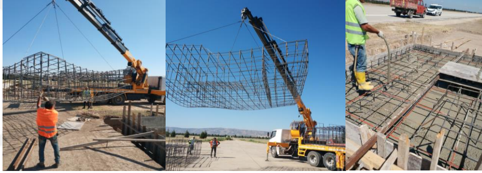
Şekil 2.47: Risksiz Alanda İmal Edilen Demir-Donatının Taşınması
