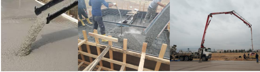
Şekil 2.49: UDS Kaidelerine Beton Uygulaması
