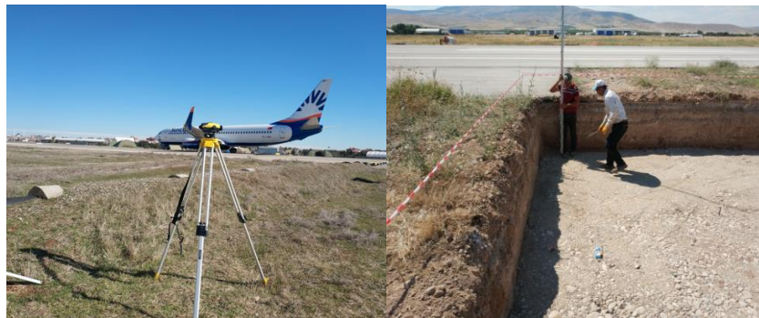
Şekil 2.41: UDS Kaide İmalatı Topografik Ölçümleri
