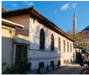
Şekil 2.35 Alemdar Paşa Medresesi fotoğrafı [127]
