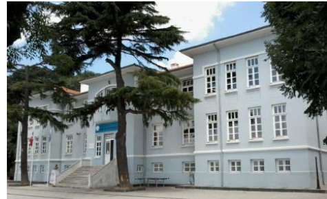
Şekil 2.56 Üsküdar 40. Mektep fotoğrafı [15]
