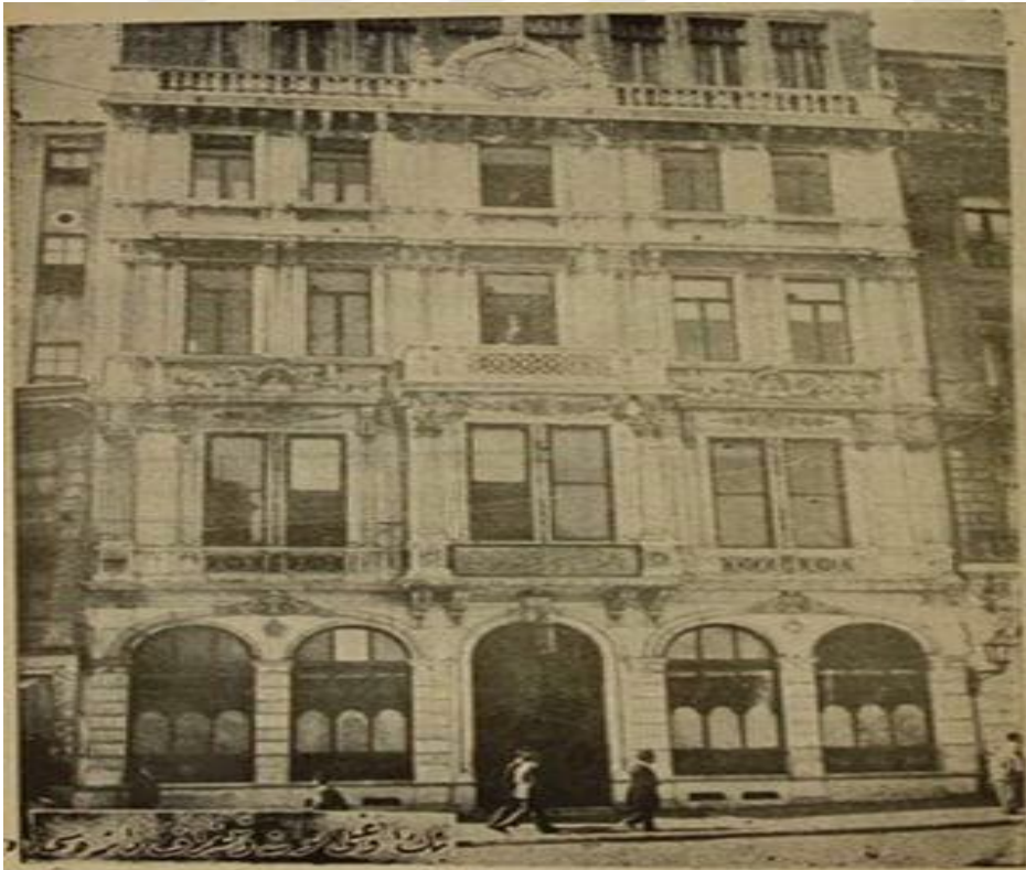
Resim 15: Beyoğlu telgrafhane binası (Türkölmez, Telekomcular Derneği, 2015)
