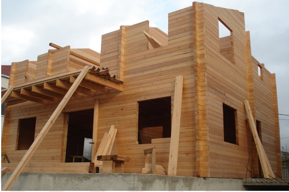
Şekil 2.3. Ahşap yığma sistemle üretilen yapı örneği [34].
