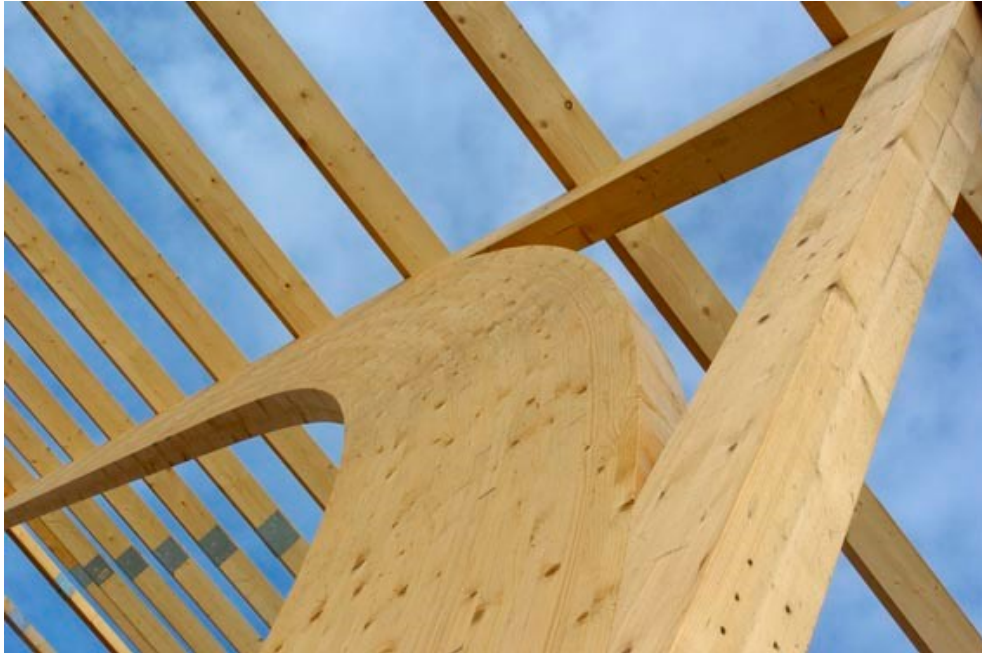
Şekil 2.11. Glulam örneği [47].
