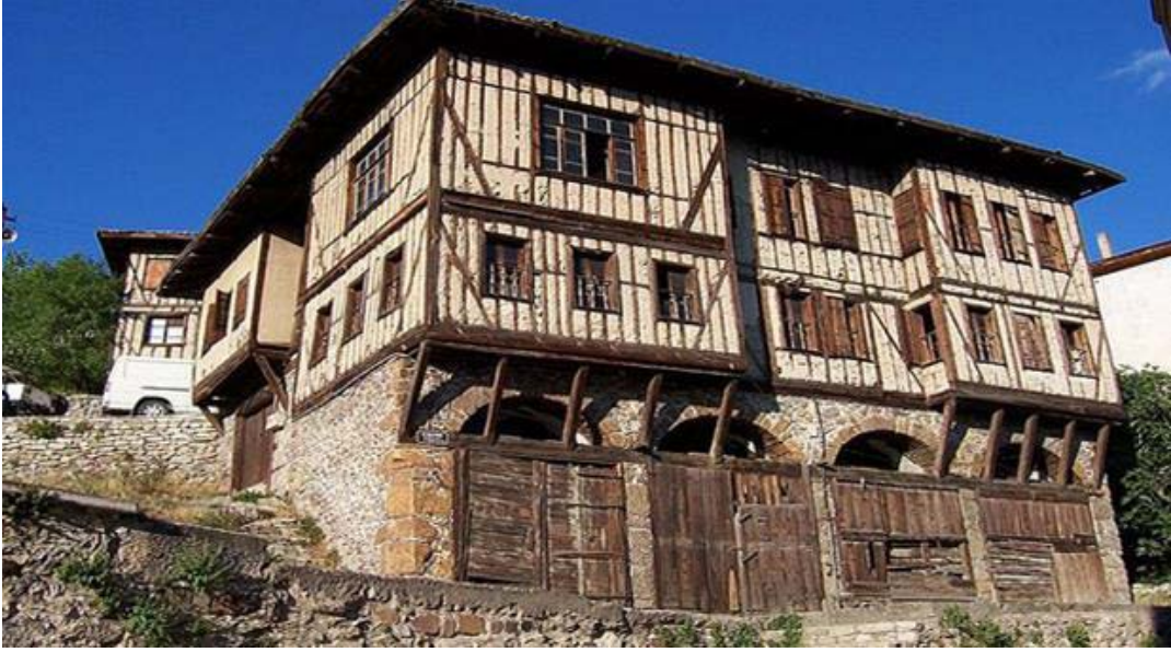
Şekil 2.8. Karma sistem yapı örneği [19].
