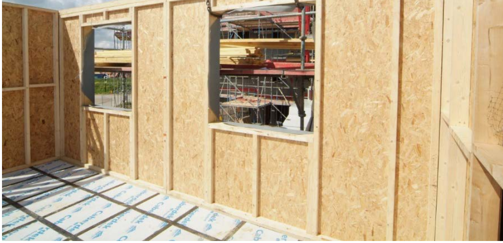
Şekil 2.7. Panel bileşen sistem yapı örneği [38].
