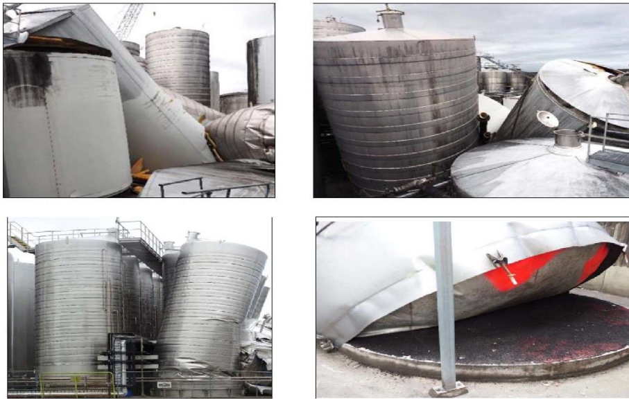
Şekil 2.7 Tank devrilme hasarları (Marlborough-2017)
