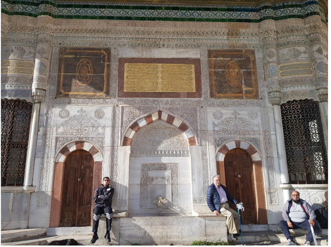
Şekil 5. 4: Sultan III. Ahmet Çeşmesi'nin mevcut görünümü (Ganbarov, A. kişisel arşivi, 2024)
