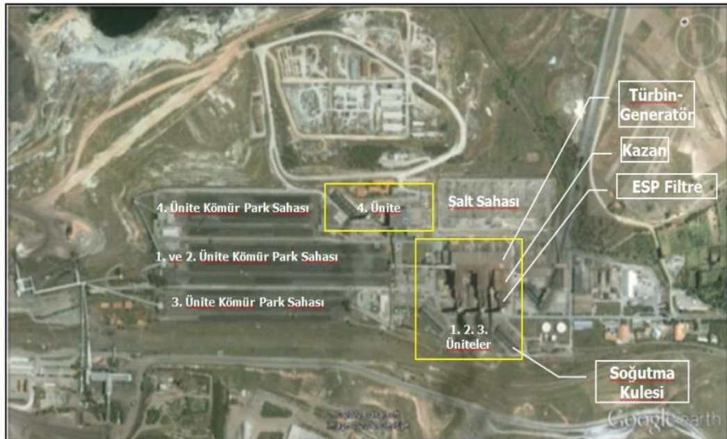
Görsel 3.1: Seyitömer Termik Santrali Genel Yerleşimi
