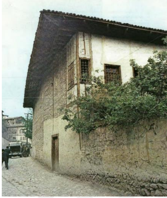
Şekil 16. Safranbolu’da bulunan Türk evinin sokak cephesi (Küçükerman 1985; Atıcı 2023)
