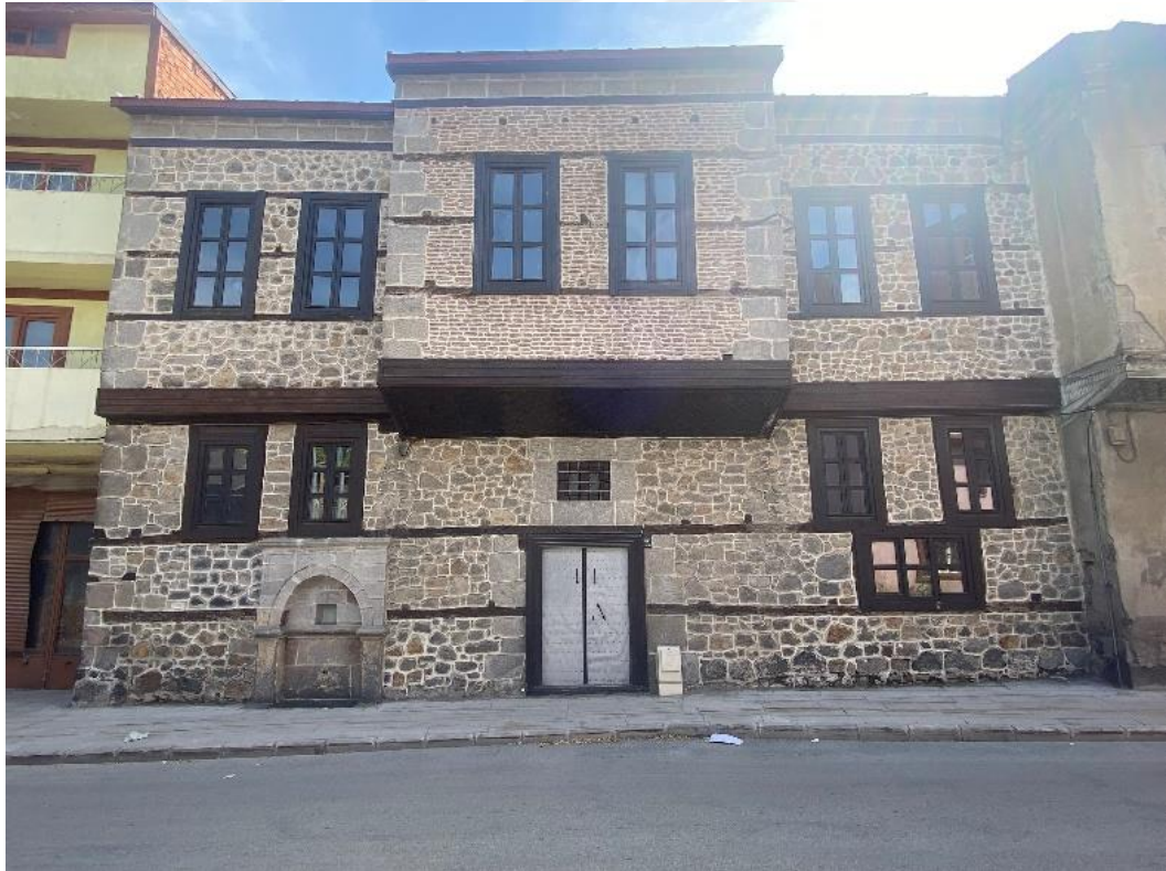
Şekil 57. 2 numaralı evde bulunan Eyvan odasının varlığı ile oluşan çıkma (Arşiv 1)
