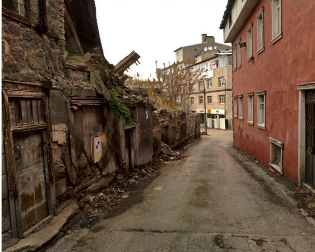
Şekil 44. Sıtkı Eminer Evi'nin ön cephesi (Arşiv 2)
