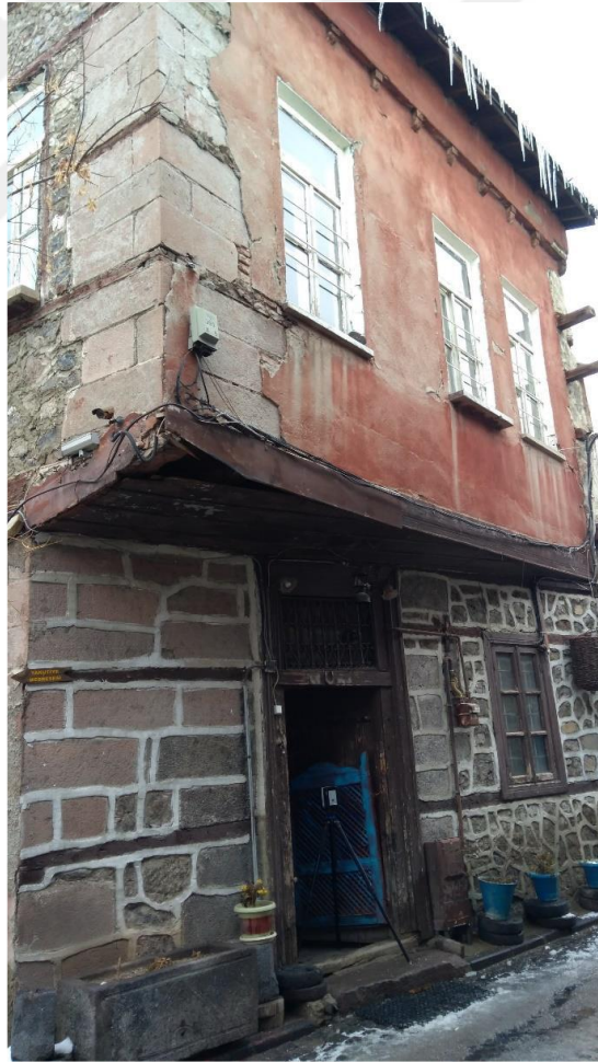
Şekil 46. Nurhayat Demir Evi'nin ön cephesi (Arşiv 2)
