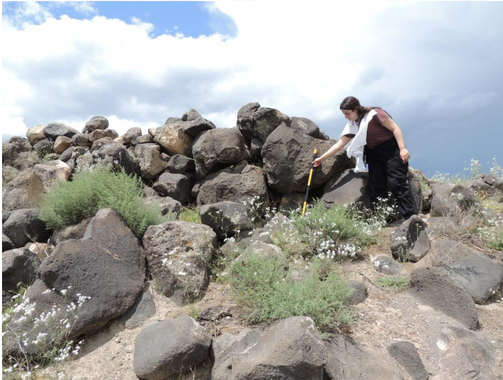
EK-8: Kasımtığı Giriş Duvarı
