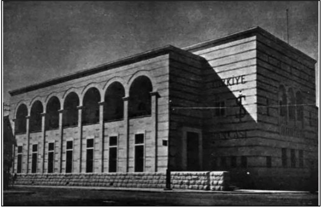
Şekil 4.7. İş Bankası binası tarihi görseli (Holtay, 1949)
