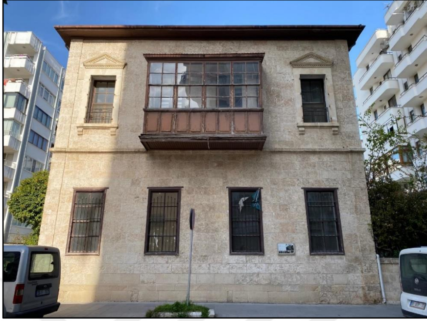
Şekil 4.4. Emniyet Müdürlüğü Lojmanı güney cephe görseli (Kişisel arşiv, 2024)
