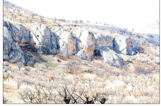
Şekil 60: Eosen kalkerlerinde çatlak sistemlerine bağlı olarak oluşan blok halindeki kaya düşmeleri (Çıpıl Tepe'den güneybatıya bakış).
