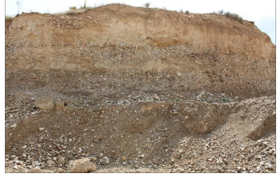
Şekil 72: Seki ve dolgularının yakından görünümü (kuzeye bakış).
