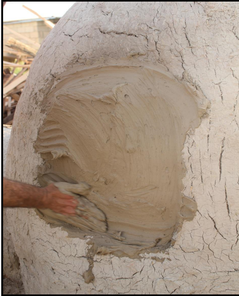
Resim 117. Ürün Besleme Penceresinin Sıvanması.
