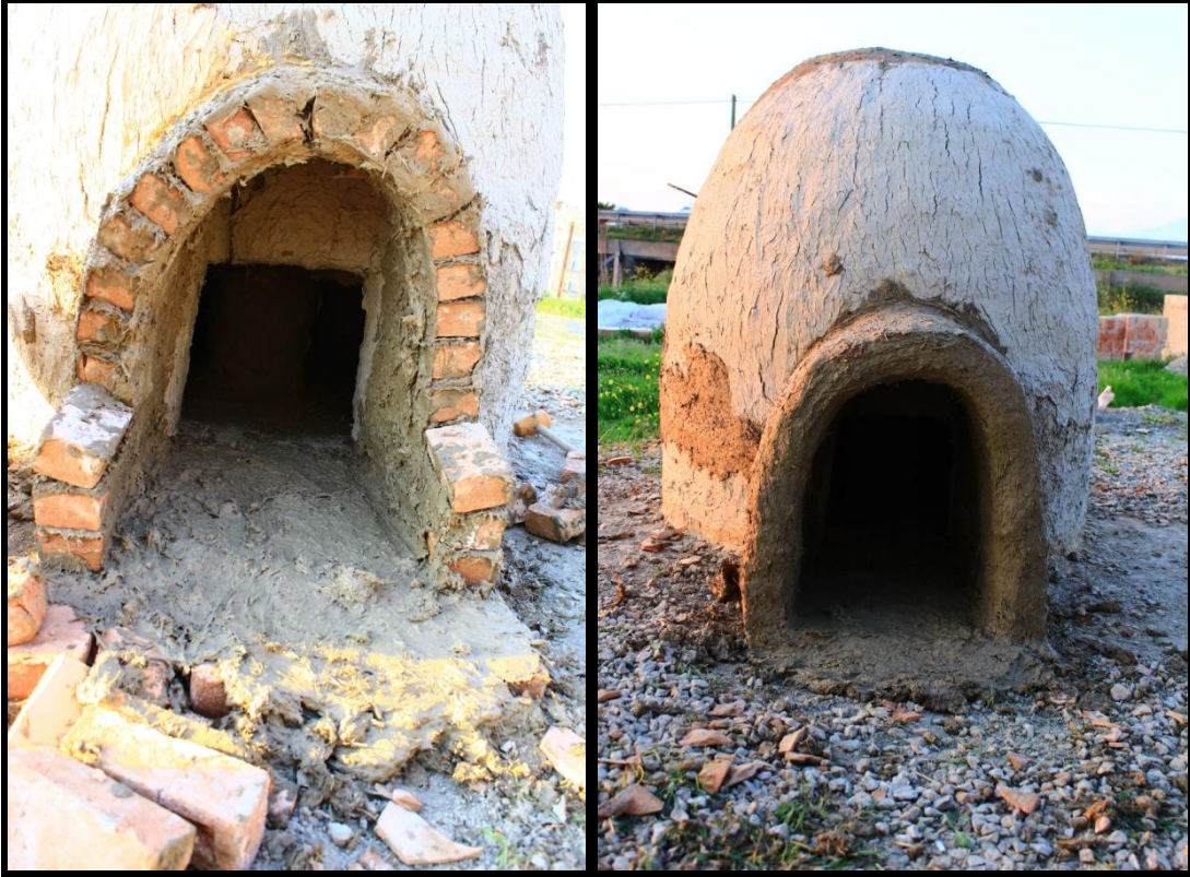
Resim 71. Fırın Ateşleme Koridorunun Yapımı.
