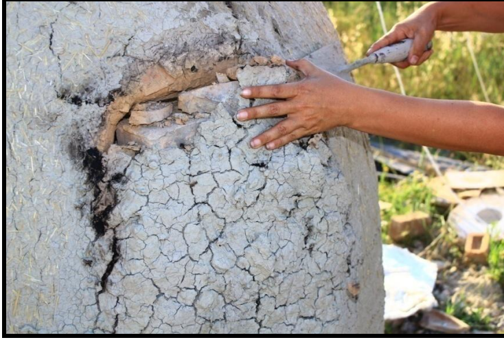
Resim 127. Ürün Besleme Penceresinin Açılması.
