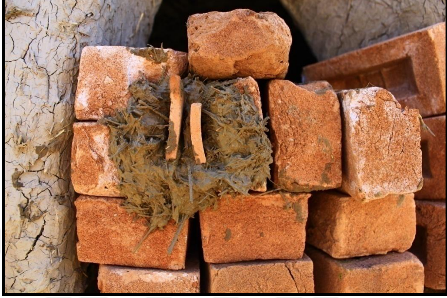
Resim 48. Fırın Sıva Uygulaması.
