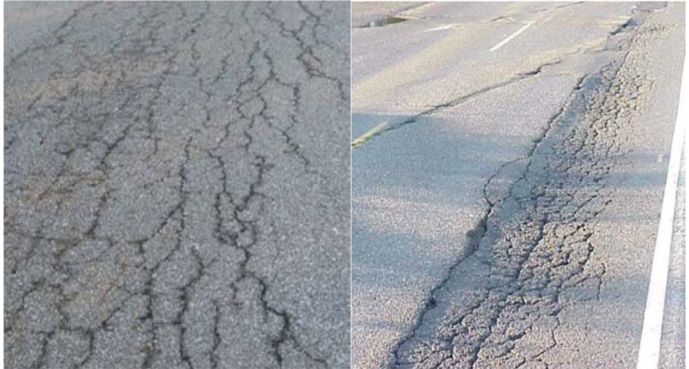
Şekil 1.1. Esnek üstyapıların bozulması (Öcal, 2014)
