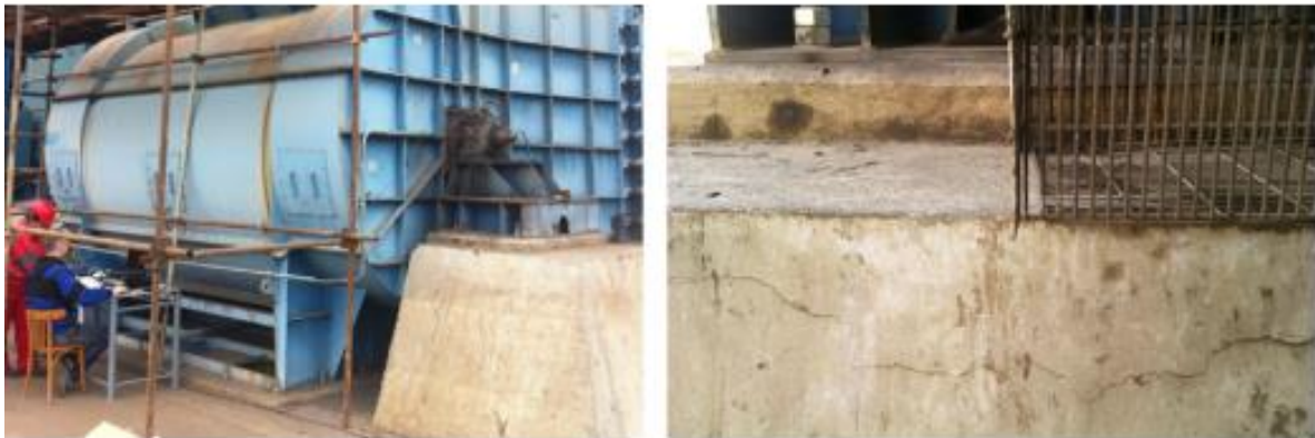
Şekil 2.3. Fan vibrasyon ölçümleri [2]
