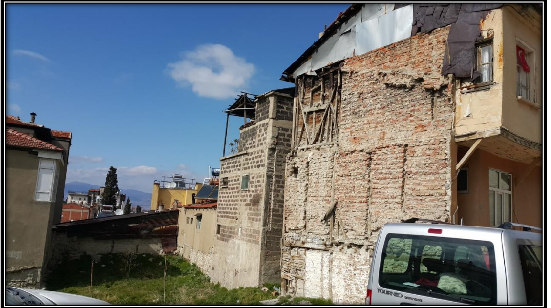
Şekil 5.21 Burdur Kentsel Sit Alanı ve Etkileme Geçiş Alanında Yığma Yapım Tekniği İle Yapılmış Yapı Örneği
