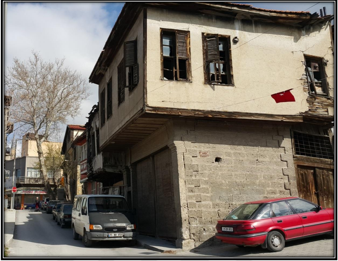
Şekil 5.7 Kentsel Sit Alanı ve Etkileme Geçiş Alanı Kesme Taş Kullanılan Sivil Mimarlık Örneği (Arazi Çalışmaları, 2016)
