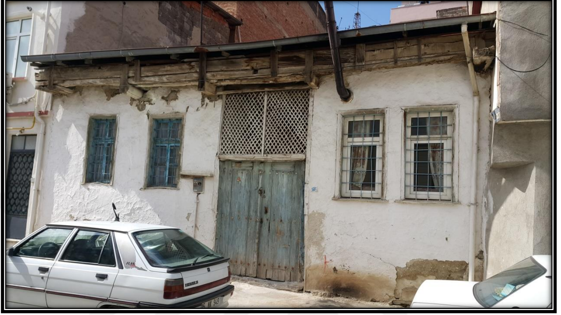
Şekil 5.20 Burdur Kentsel Sit Alanı ve Etkileme Geçiş alanında Ahşap Malzeme kullanılan Yapı Örneği
