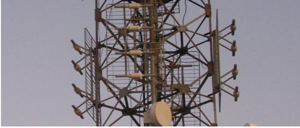
Şekil 2.10. Kathrein firmasına ait K 52 33 57 kodlu antenin saha fotoğrafı
