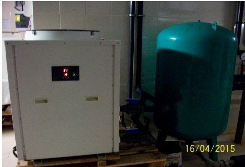
Şekil 6.6 Eti sualtı dünyası mağara akvaryumu soğutucusu (Orijinal,2015)
