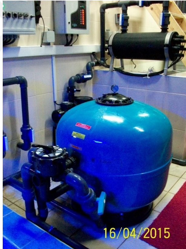
Şekil 6.11 Eti sualtı dünyası kum filtre sistemi (Orijinal, 2015)
