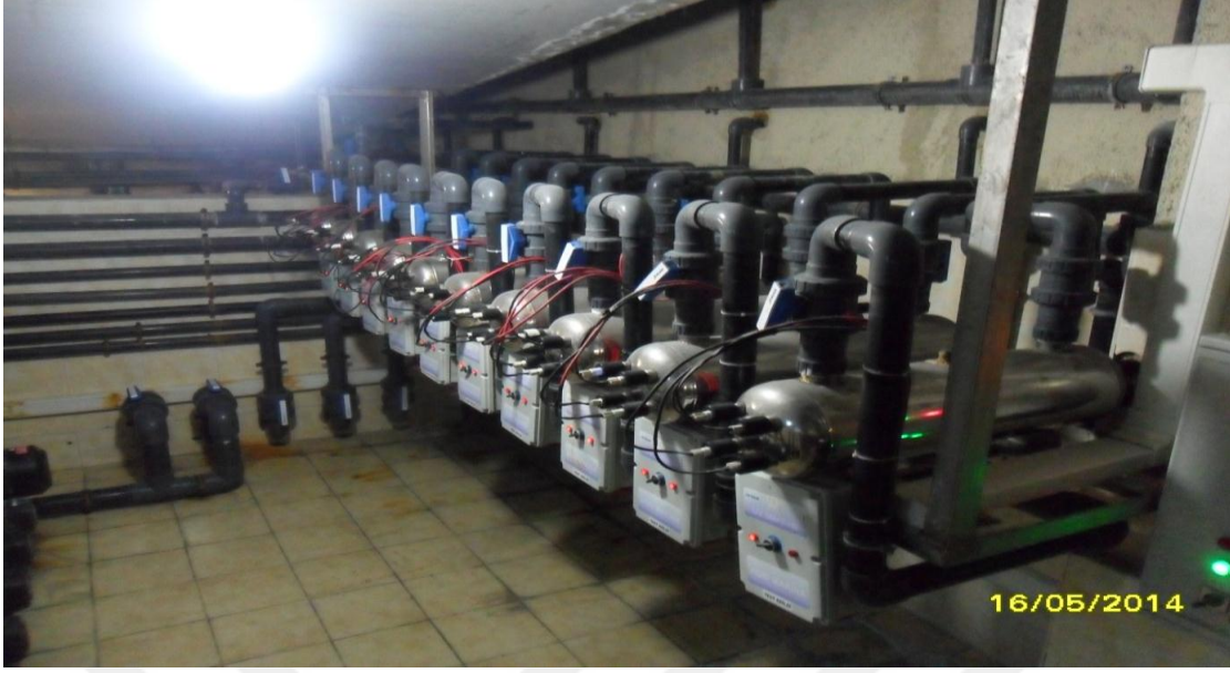
Şekil 6.4 Nata Vega akvaryum ultraviyole ünitesi (Orijinal, 2015)
