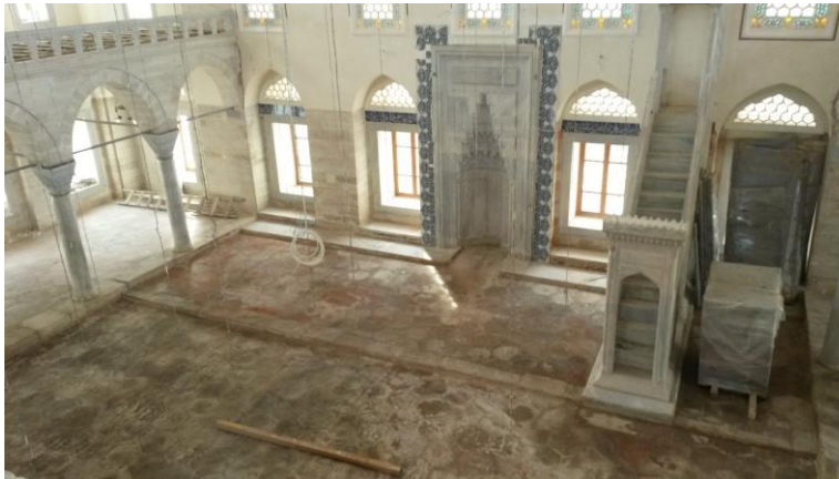
Şekil 5.18 : Zal Mahmut Paşa Camii, Nisan 2015’te restorasyon sırasında çekilen bir fotoğraf.
