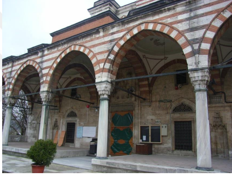
Şekil 2.5 : Zal Mahmut Paşa son cemaat yeri almaşık kemer uygulaması.
