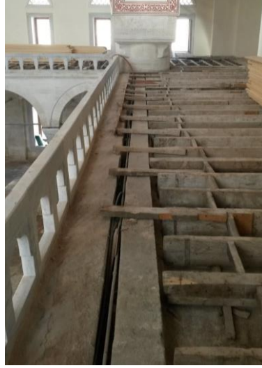
Şekil 5.19 : Zal Mahmut Paşa Camii, onarılan gerginin bulunduğu kadınlar mahfili döşemesi.
