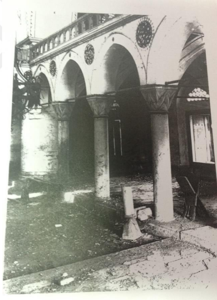
Şekil 5.10 : Zal Mahmut Paşa Cami, 1940'lı yıllarda çekilen zemin katı fotoğrafı [112].
