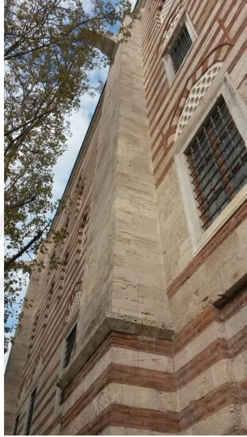
Şekil 5.16 : Zal Mahmut Paşa Camii,dışı taş kaplı betonarme payanda.
