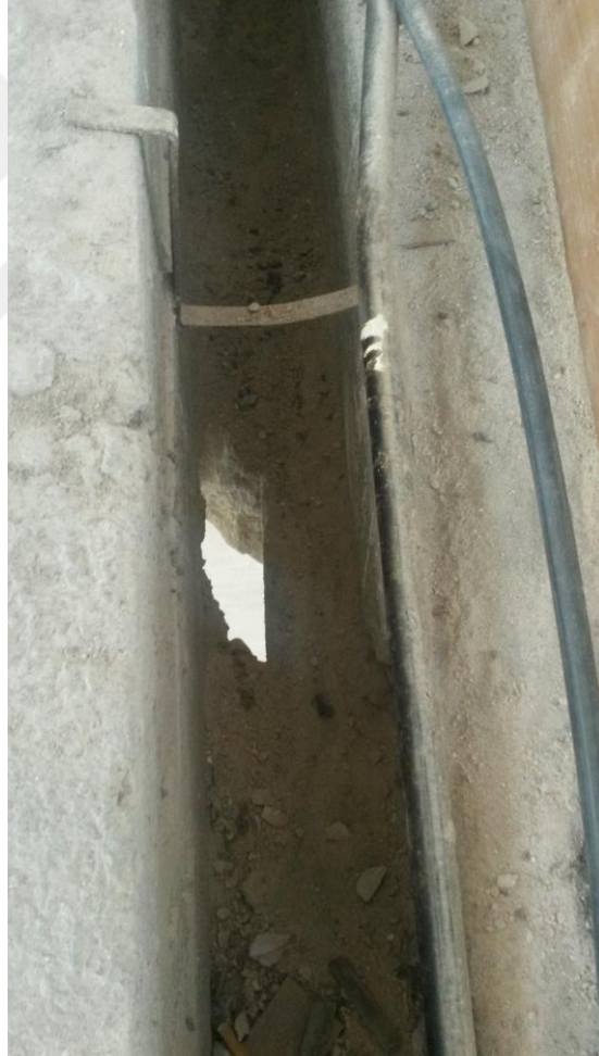
Şekil 5.20 : Zal Mahmut Paşa Camii, 1960'lı yıllarda tamir edildikten sonra bakımı yapılması için açıkta bırakılan gergi demirinin günümüzde ilk tespit edildiği an.
