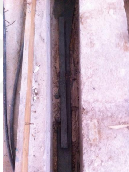
Şekil 5.22 : Zal Mahmut Paşa Camii, 1960'lı yıllarda onarılan gergi demirinin bakımı yapıldıktan sonraki hali.
