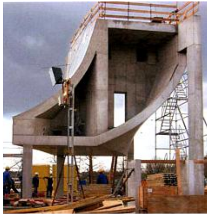
Şekil 3.51 : 1/1 Ölçekli Deneme Dökümü, (Van Berkel ve Bos, 2006b, s. 152).
