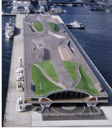
Şekil 3.18 : Yokohama Feribot Terminali Genel Görünüm, (Url-21).
