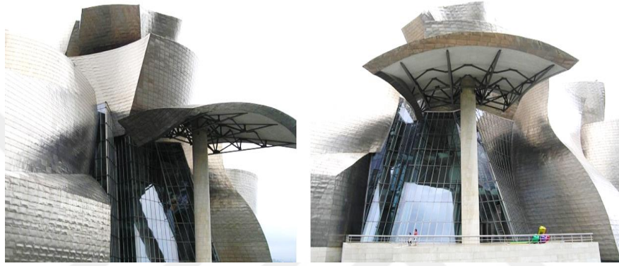
Şekil 3.9 : Kuzey Cephesindeki Saçak ve Taşıyıcısı.
