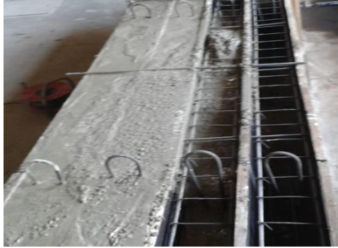
Şekil 3.10. Numunelere beton döküm aşamasından bir görünüm
