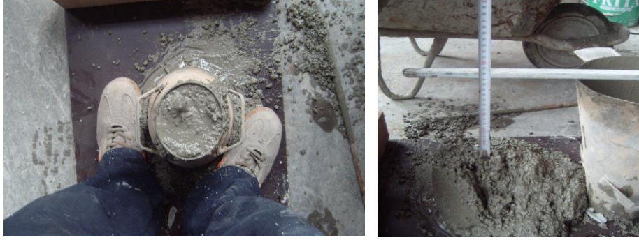
Şekil 3.2. Slump deneyinin yapılması
