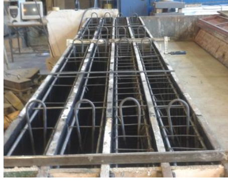
Şekil 3.9. Beton dökümü için hazırlanan kiriş numunelerinden bir görünüm
