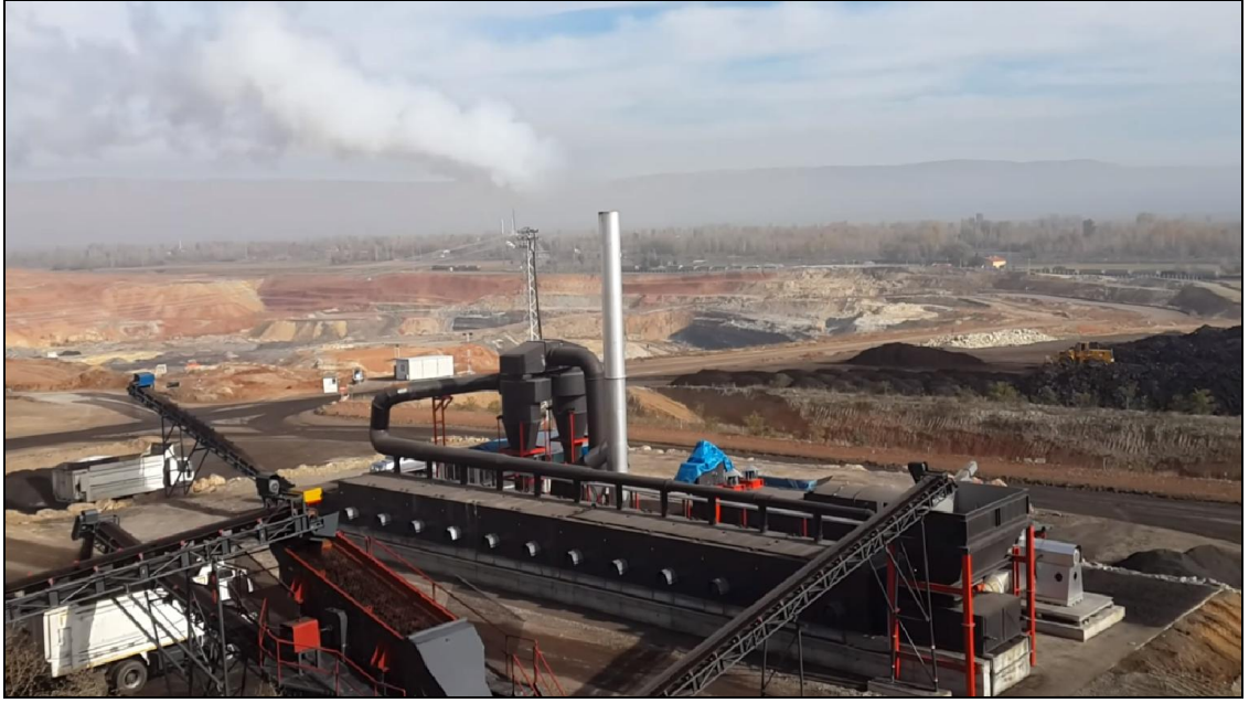
Şekil 2.6. Ilgın Linyit İşletmesinde kurulan asos döner bantlı özel dizayn parça kömür kurutma tesisi
