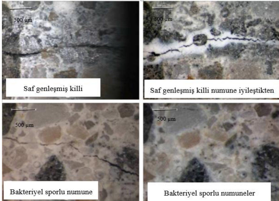
Resim 2.14.Çatlaklarda kalsiyum karbonat oluşması ve çatlakların iyileşmesi
